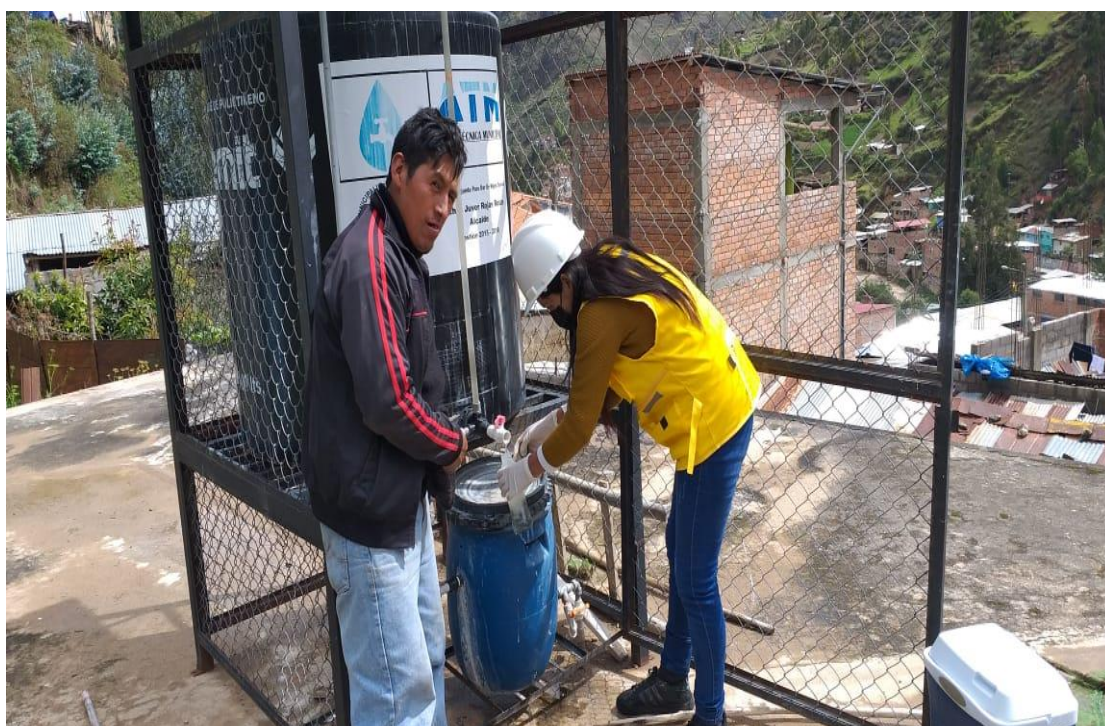
Ilustración 4: Reservorio en la casa de una de las Viviendas de un poblador de Huariaca
