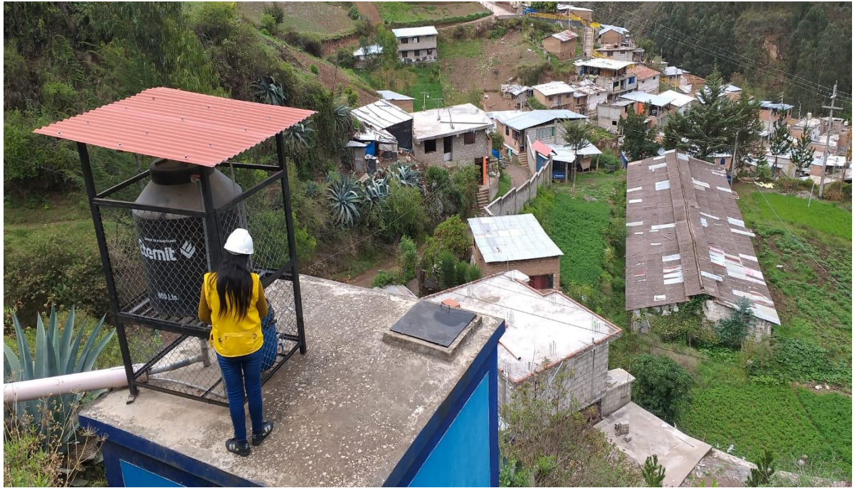
Ilustración 9: Tanque de Almacenamiento de Agua de la zona de Yanacocha
