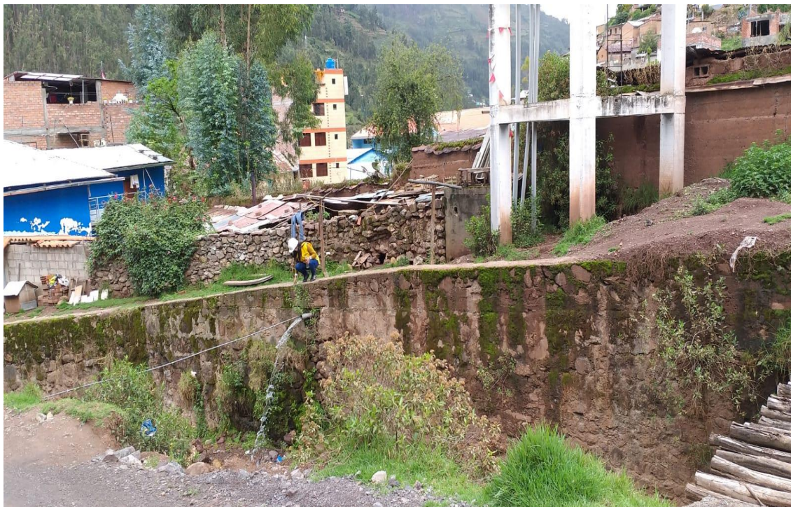
Ilustración 5: Las descargas del agua de rebose de los reservorios son vertidas a los ríos
