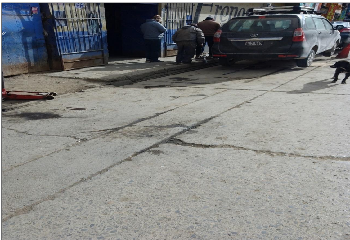
Imagen N° 12: Vista del impacto al suelo, cuyos lixiviados llegan a la alcantarilla
