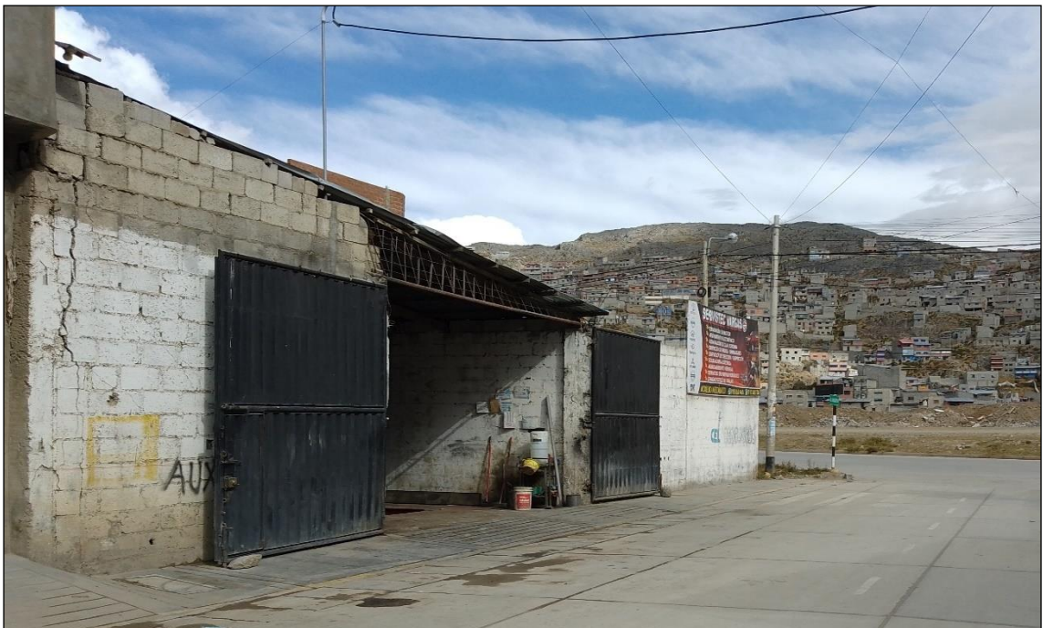
Imagen N° 9: Vista del impacto al suelo, cuyos lixiviados llegan a la alcantarilla
