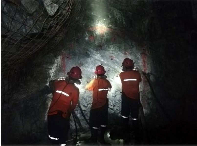
Figura N° 13: Seguimiento de la profundidad y paralelismo de los taladros.
