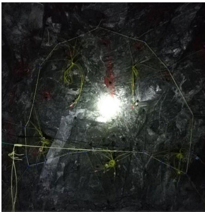
Figura N° 16: Carguío de los taladros y control de sobrerotura.
