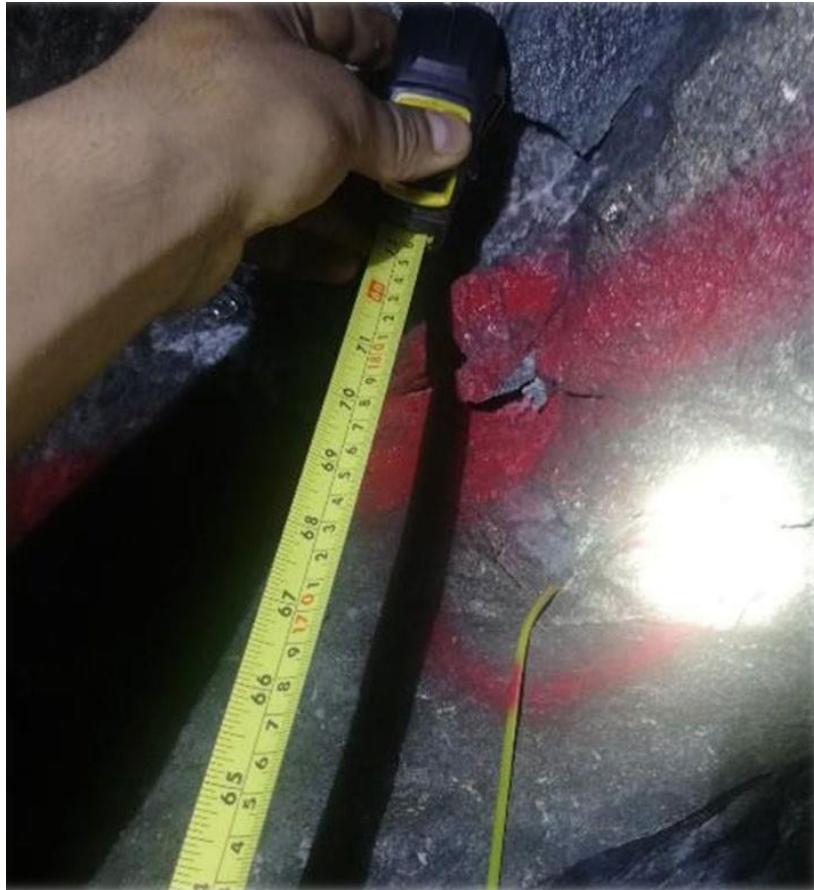
Figura N° 12: Dimensionamiento de la labor y pintado de la malla.
