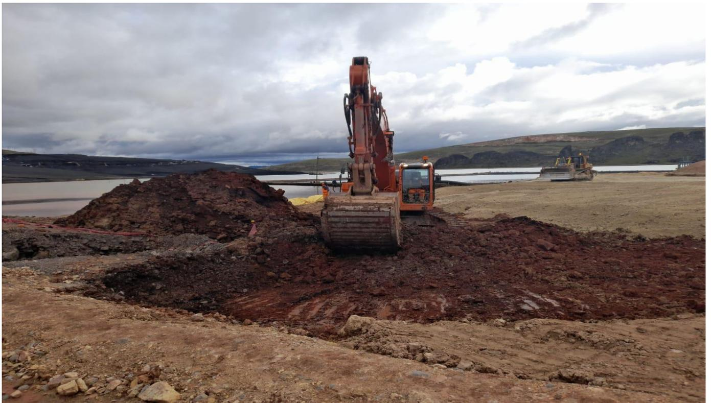
**Fotografía N° 10:** *Preparación del terreno de fundación para instalar material competente.*
