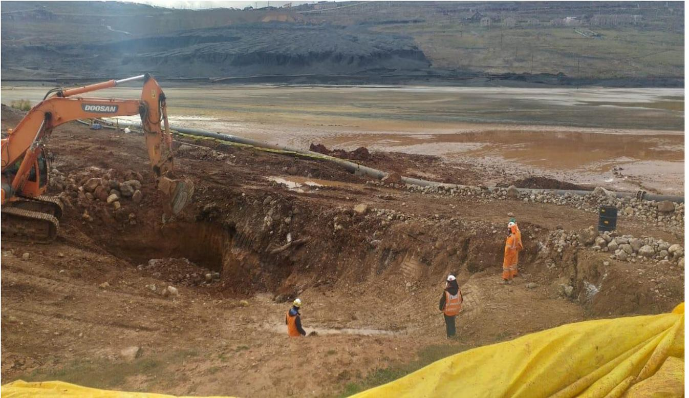
**Fotografía N°05:** Excavación de calicatas para un analisis de suelos completo.
