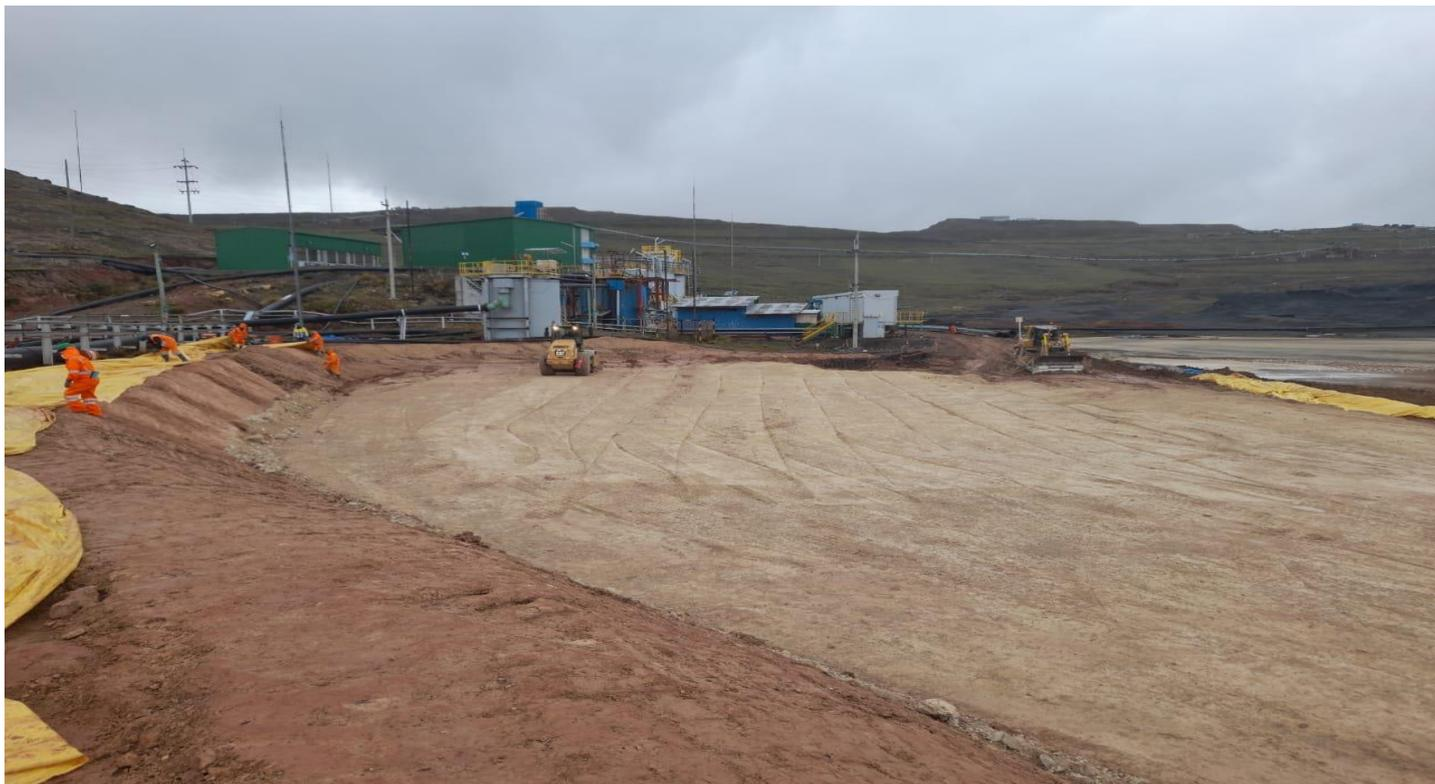
**Fotografía N° 11:** compactado del terreno con 8 ciclos que es la apropiado por el estándar realizado al material con ayuda del proctor.
