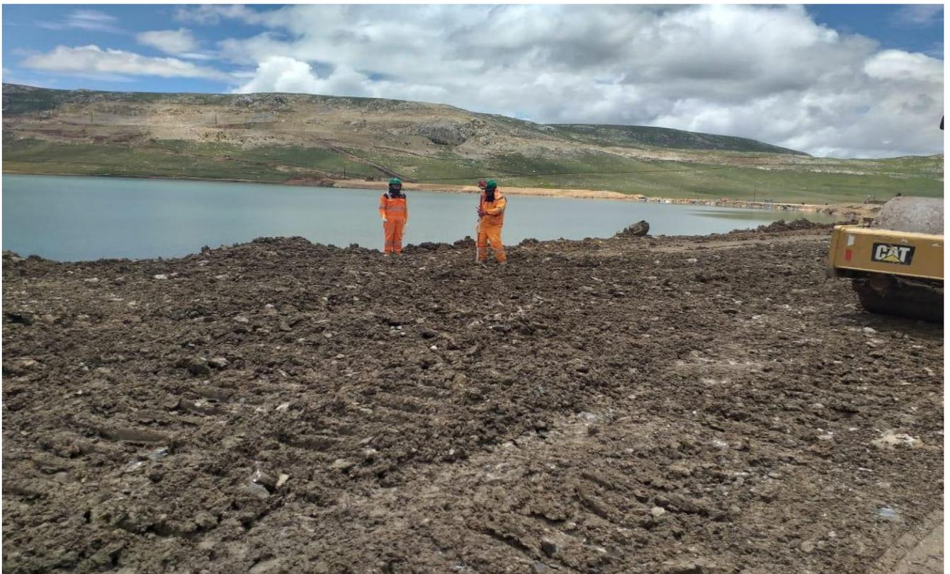
**Fotografía N° 06:** Control topográfico del material extraído de Pasamayo
