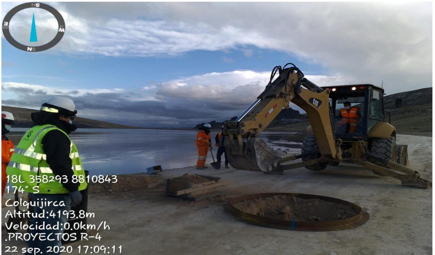
*Fotografía N° 07: Excavación para la prueba de densidad por reemplazo por agua.*
