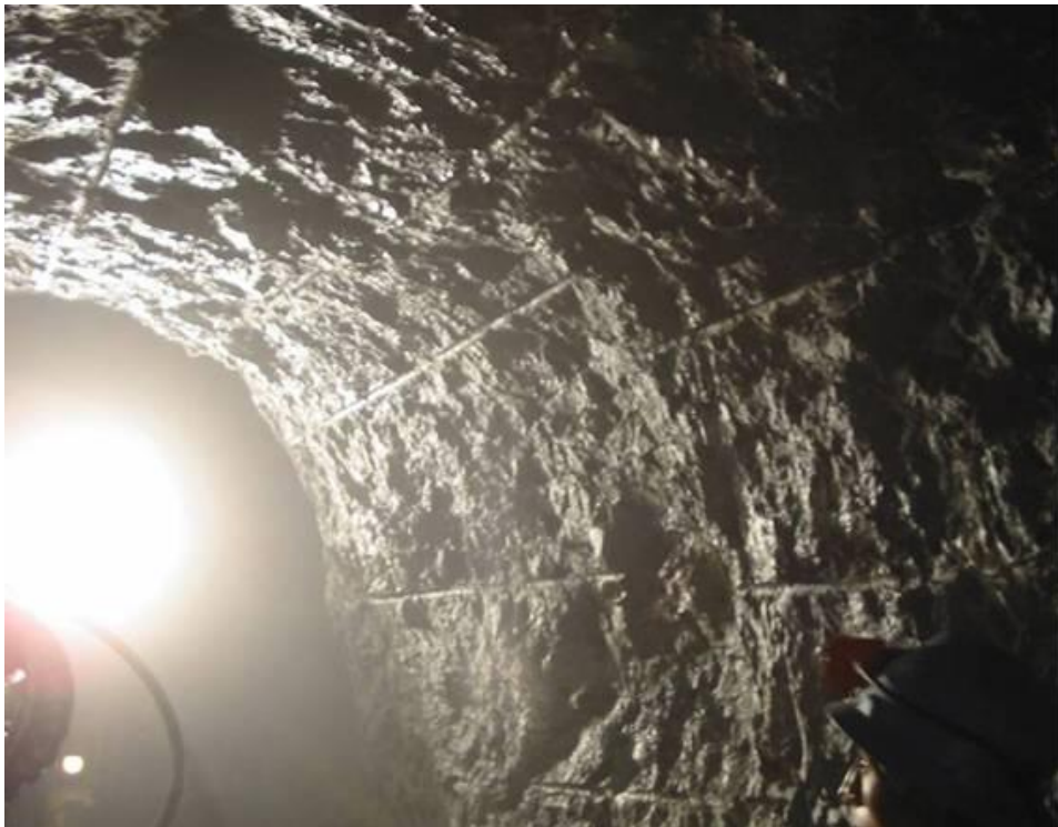
Figura 26: Fotografía del resultado del perfil de la voladura con rediseño
