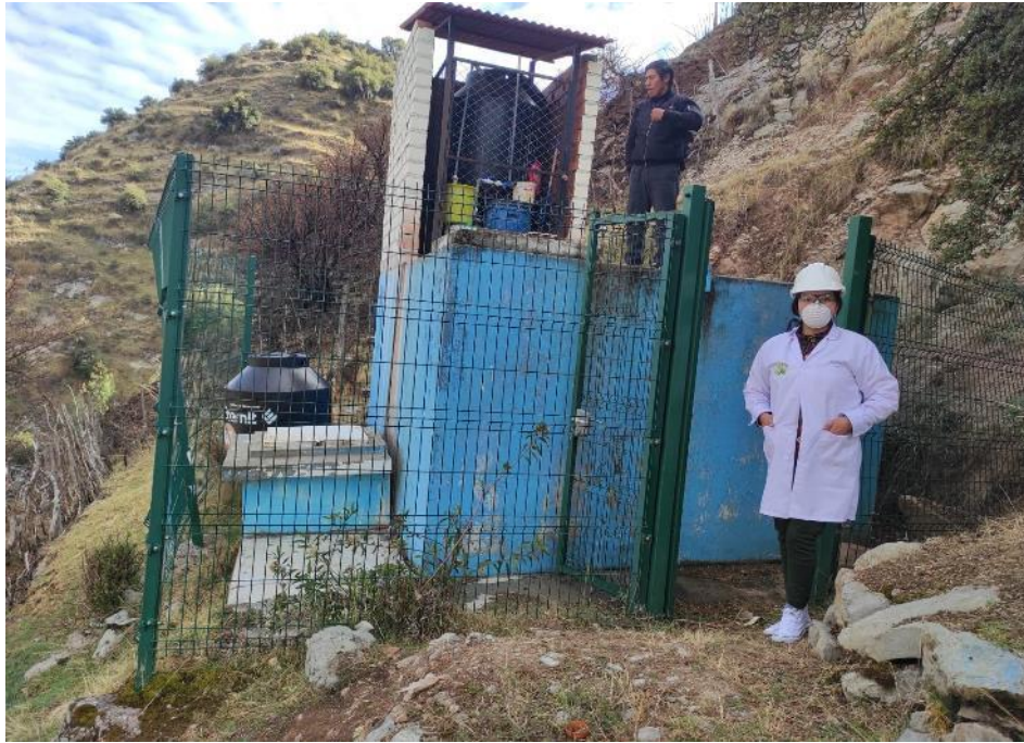
Fig. 12 Reservorio de la localidad de 30 de Agosto
