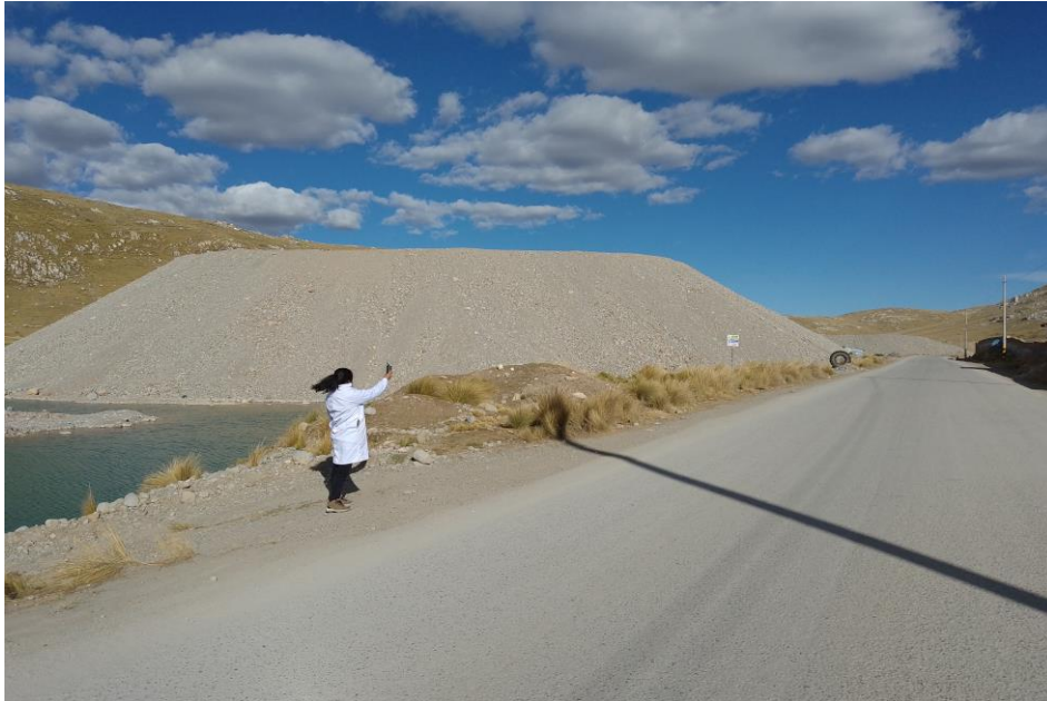
Fotografía N° 7: Acumulación de arena
