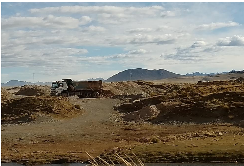
Fotografía N° 8: Despacho de arena fina, gruesa y piedra
