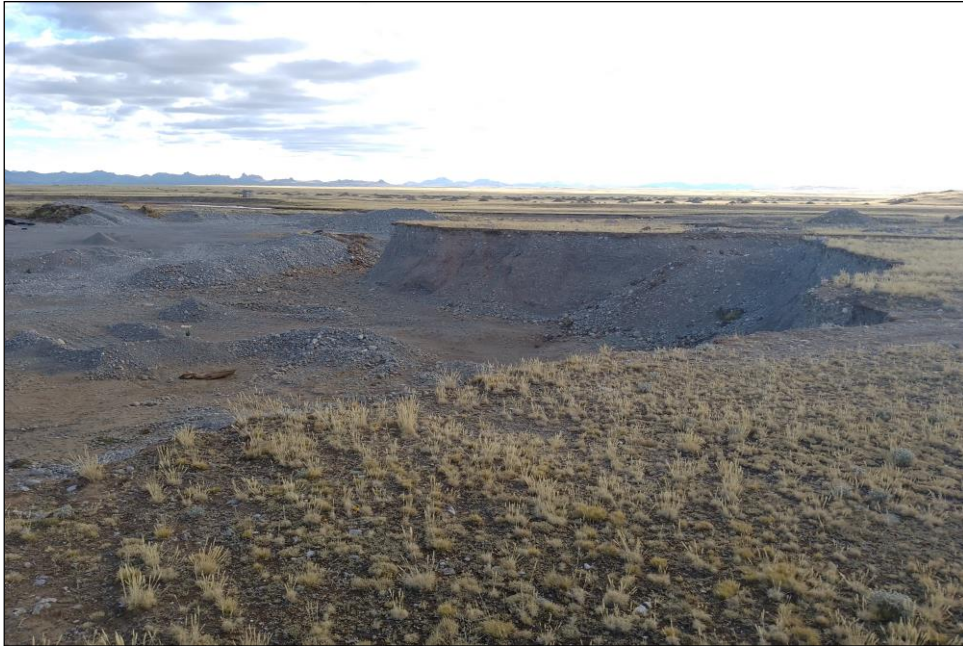
Fotografía N° 2: Área sin retiro adecuado de top soil
