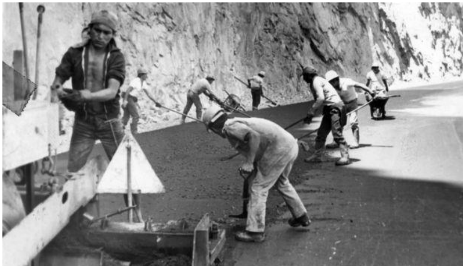
Imagen 01: Construcción de Carretera Central
