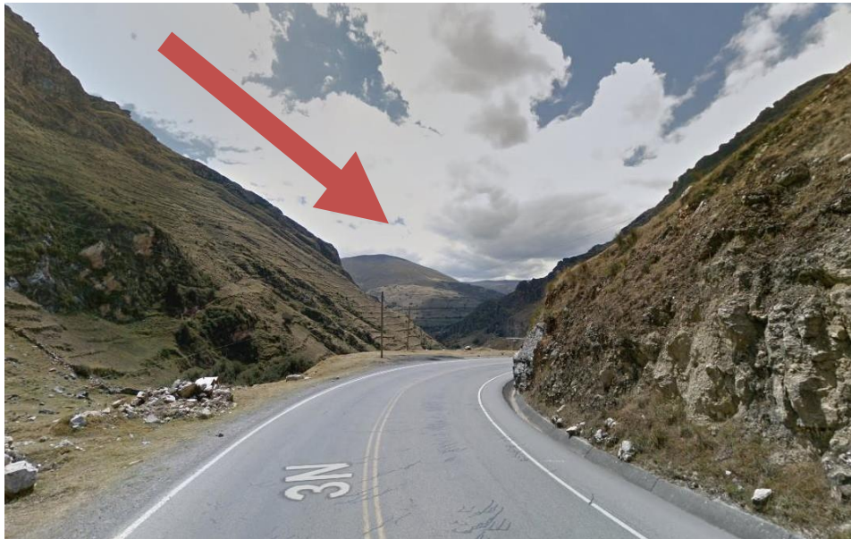
Imagen 04: Foto, metros antes de la curva, sentido Pasco - Huánuco
