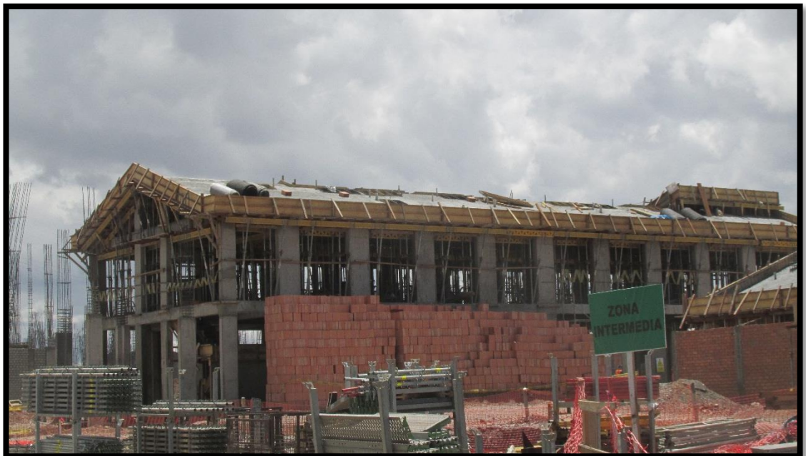
Fotografía 8: Acabado Final luego del vertido de concreto en el segundo techo del Venustero de RCE
