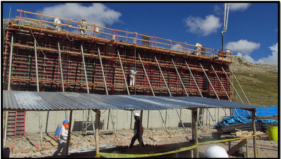
Fotografía 6: Vertido de concreto en Cerco Pasarela segundo Nivel Alcanzando la Altura de H= 7.50m .
