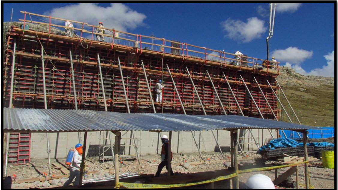
Fotografía 4: Vertido de concreto en Cerco Pasarela segundo Nivel Alcanzando la Altura de H= 7.50m.
