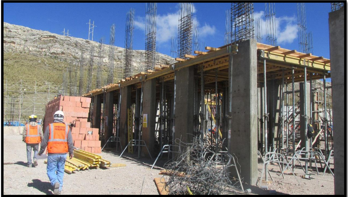
Fotografía 5: Encofrado de losa aligerada en Venustierio de RCE.
