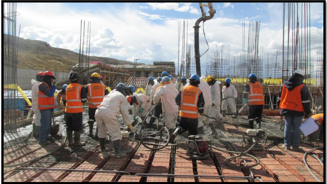
Fotografía 9: Mala distribución de personal en vaciado de concreto en techos, significado de tiempo No Contributorio.
