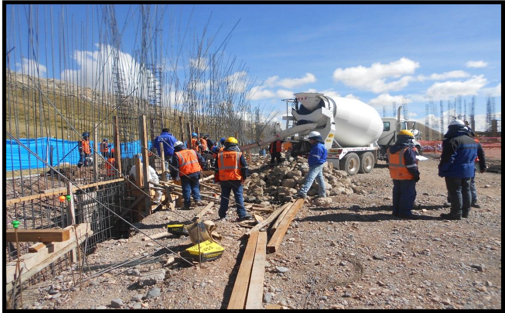
Fotografía 7: Verificación de los trabajos en campo en la partida vertido de concreto en el cerco Pasarela.
