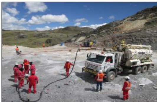
Carguío de los taladros para la voladura
