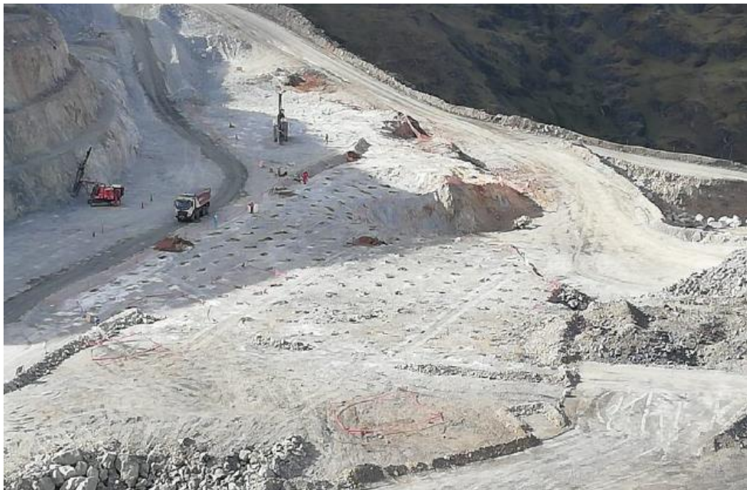
Taladros perforados en el Tajo San Gerardo
