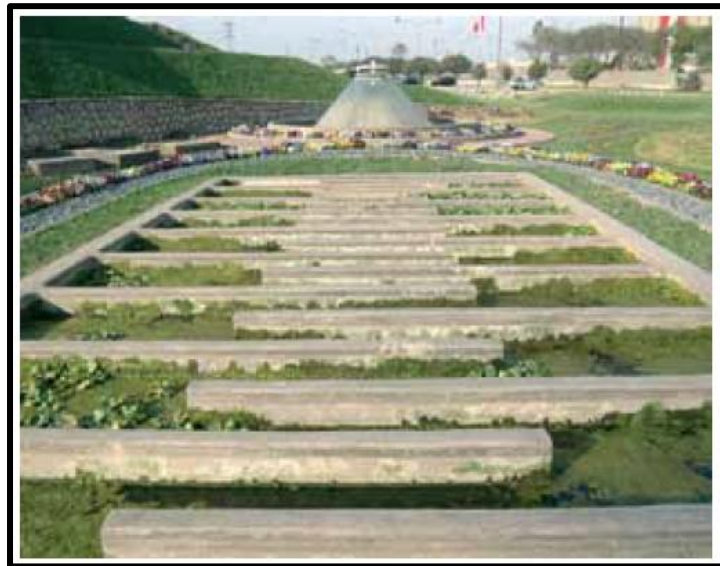
Figura 1: Vista panorámica de un Sistema de Tratamiento de Aguas Residuales domésticas, implementado en el distrito de San Borja - Lima.
