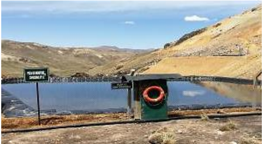
Imagen 15: Poza de Monitoreo, la misma que corresponde a la poza donde se encuentra el agua tratada, el agua por rebose pasa al sistema tipo wetland para posteriormente ser derivadas a la quebrada Lluchusani, mediante la estación de monitoreo V-J
