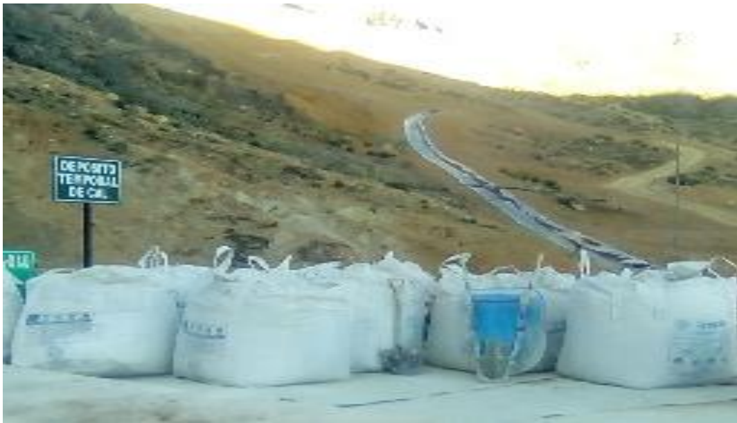
Imagen 5: Se observa que los sacos de óxido de calcio (cal), se encuentra en una base de concreto, ello con el fin de evitar que el material entre en contacto con el suelo natural de la zona, asimismo cuenta con un peldaño elevado con el fin de asegurar la estabilidad.
