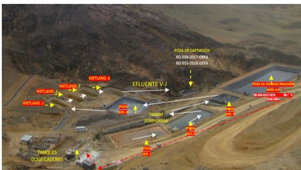
Fotografía 1: Vista panorámica del Sistema de Tratamiento de Aguas Acidas – Wetland Jessica.
