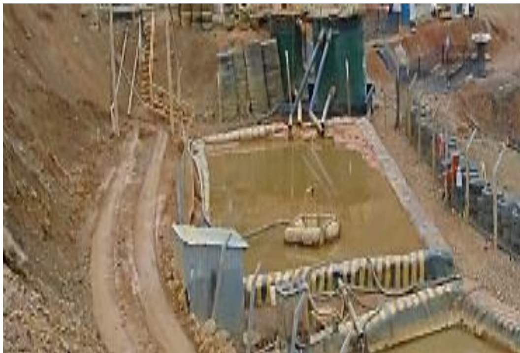
Imagen12: Se observa la Poza de sedimentación N° 3, poza donde se recepciona las aguas tratadas para la primera etapa. Capacidad de 866m 3 .
