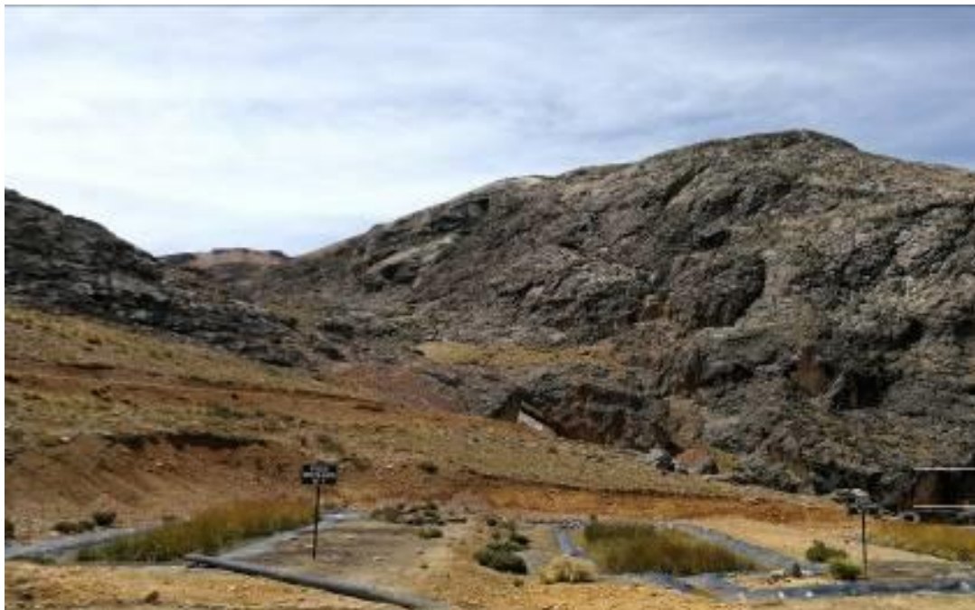
Imagen 16: Se observa las 02 pozas de secado de lodos que se tiene implementada, en las mismas se dispone los lodos semilíquidos, provenientes de las diferentes pozas de sedimentación del sistema de tratamiento de aguas acidas. 1300 m3 cada una.
