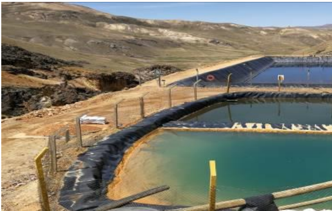
Imagen 14: Poza de sedimentación N° 5, poza donde se recepción las aguas tratadas de la segunda etapa del tratamiento. Capacidad de 860 m 3 .
