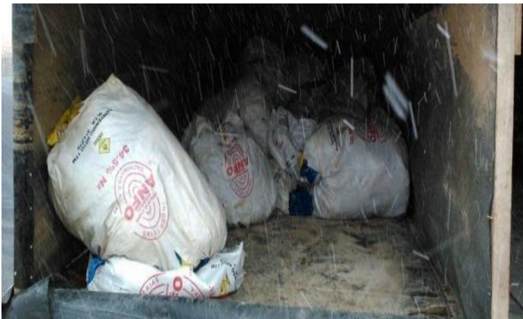
Imagen 4: Se observa el almacén temporal de hidróxido de sodio, el cual se encuentra bajo techo. Asimismo, se cuenta con un centro de acopio de residuos peligroso.
