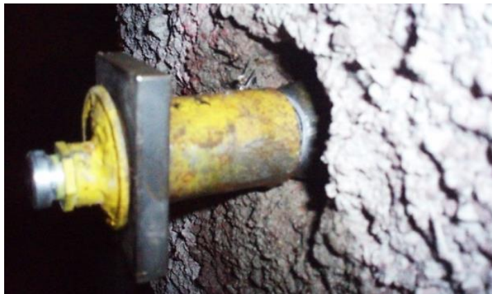
Figura N° 23: Perno Hydrabolt después de la prueba.
