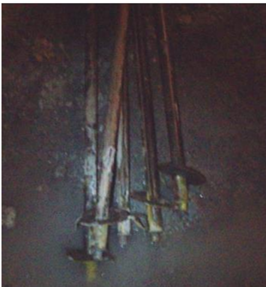
Figura N° 58: Pernos colocados verticalmente no es el adecuado.
