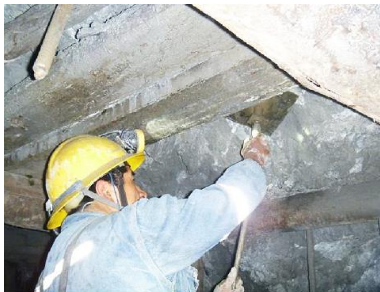
Figura N° 27: Instalación del Hydrabolt.
