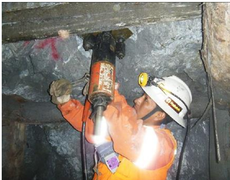
Figura N° 30: Instalado correcto de equipo Pull Test.
