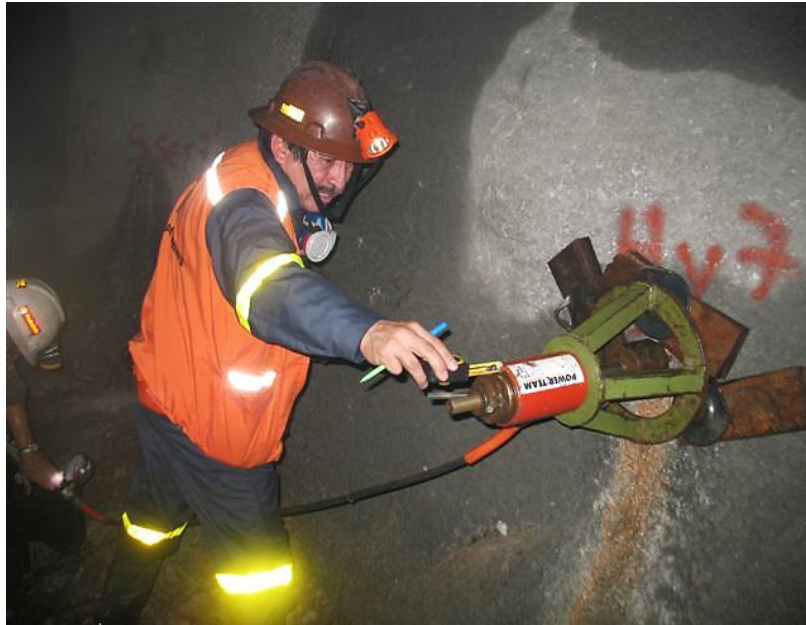
Figura N° 15: Perno Hydrabolt instalado.
