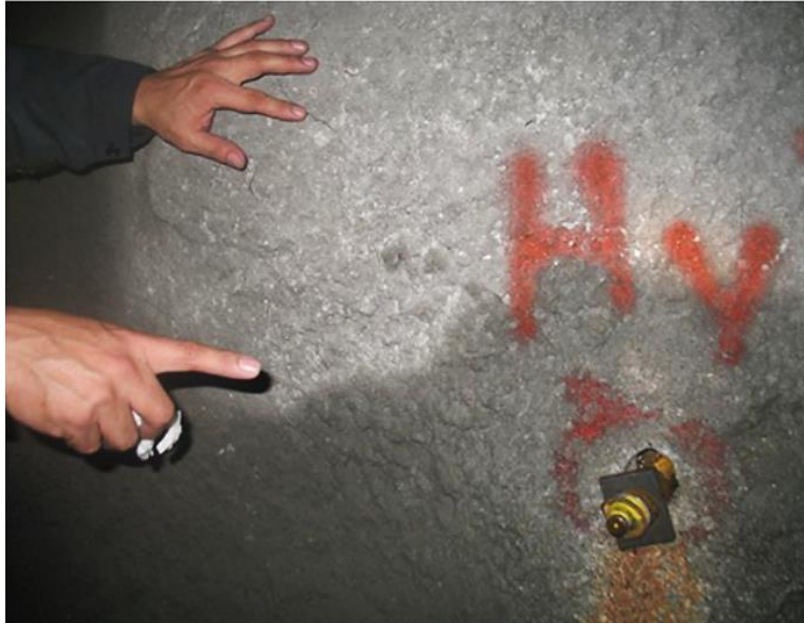
Figura N° 36: Prueba de arranque del perno Hydrabolt.
