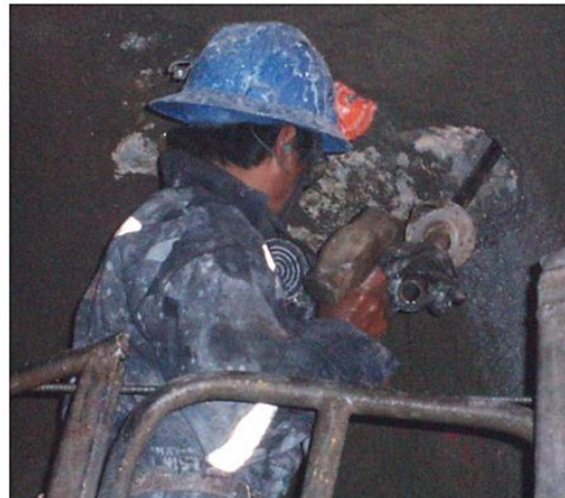
Figura N° 59: Instrumentos combo, empujador para instalar los pernos no son los adecuados.
