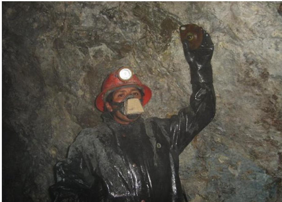
Figura N° 5: Perno Hydrabolt instalado.
