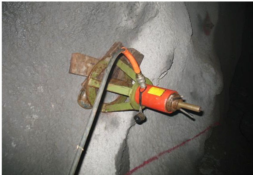
Figura N° 13: Prueba de esfuerzo del perno.
