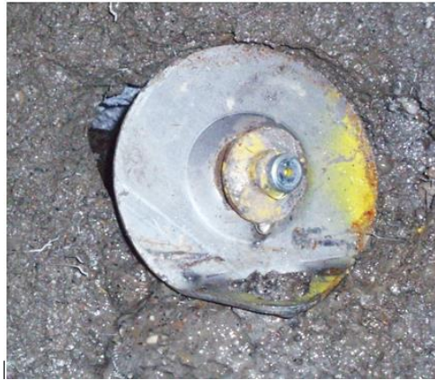
Figura N° 60: Perno Hydrabolt colocados en forma forzada.
