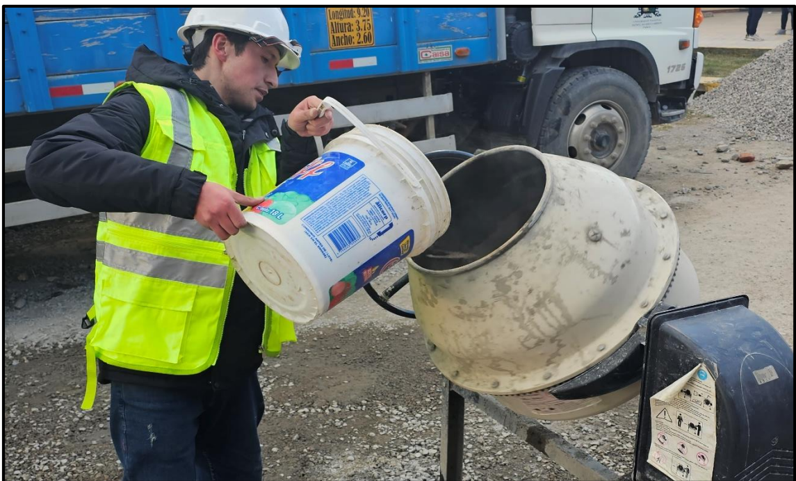
Fotografía 26.- Echado de los materiales a la mezcladora de concreto.
