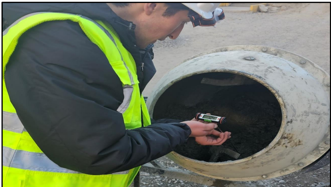
Fotografía 28.- Medición de la temperatura del concreto fresco.
