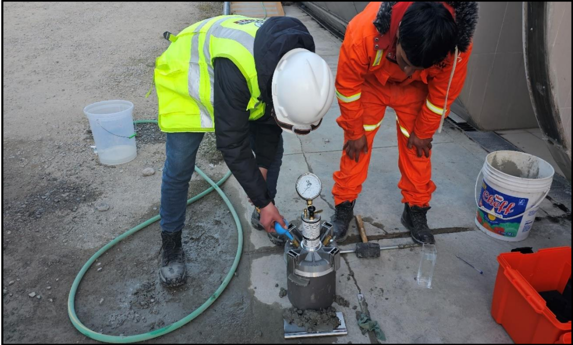
Fotografía 35.- Prueba de medición de contenido de aire con la Olla de Washington.
