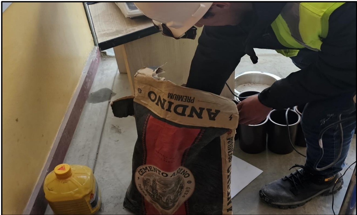
Fotografía 21.- Peso del material cemento para la elaboración del concreto.
