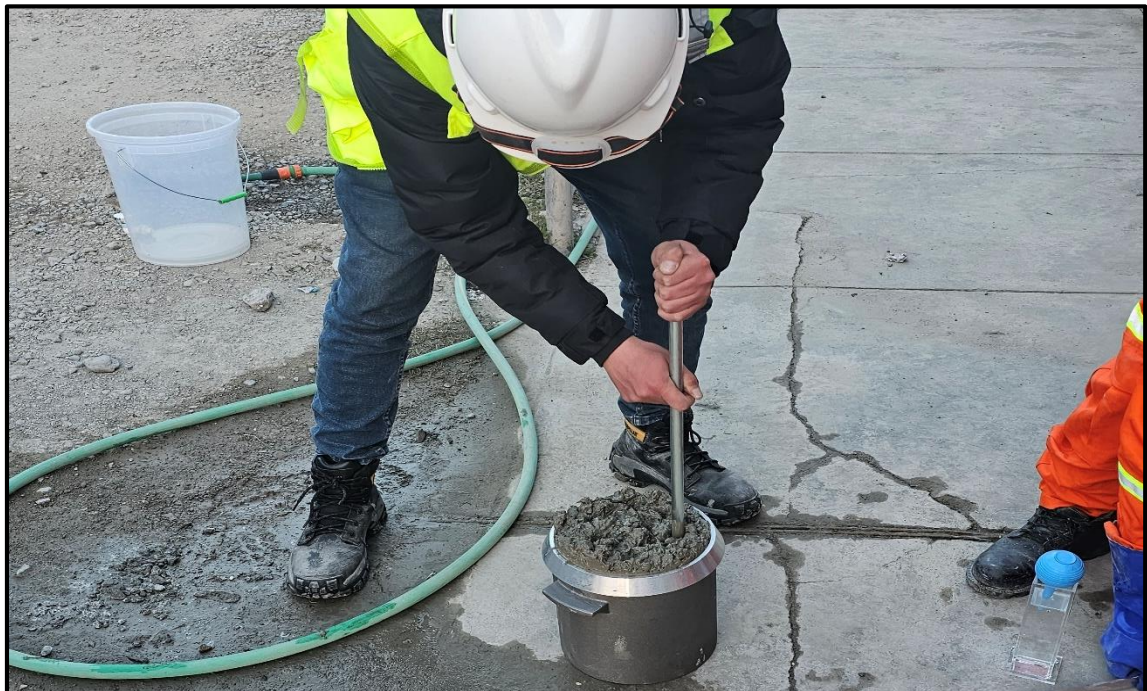
Fotografía 34.- Prueba de medición de contenido de aire con la Olla de Washington.
