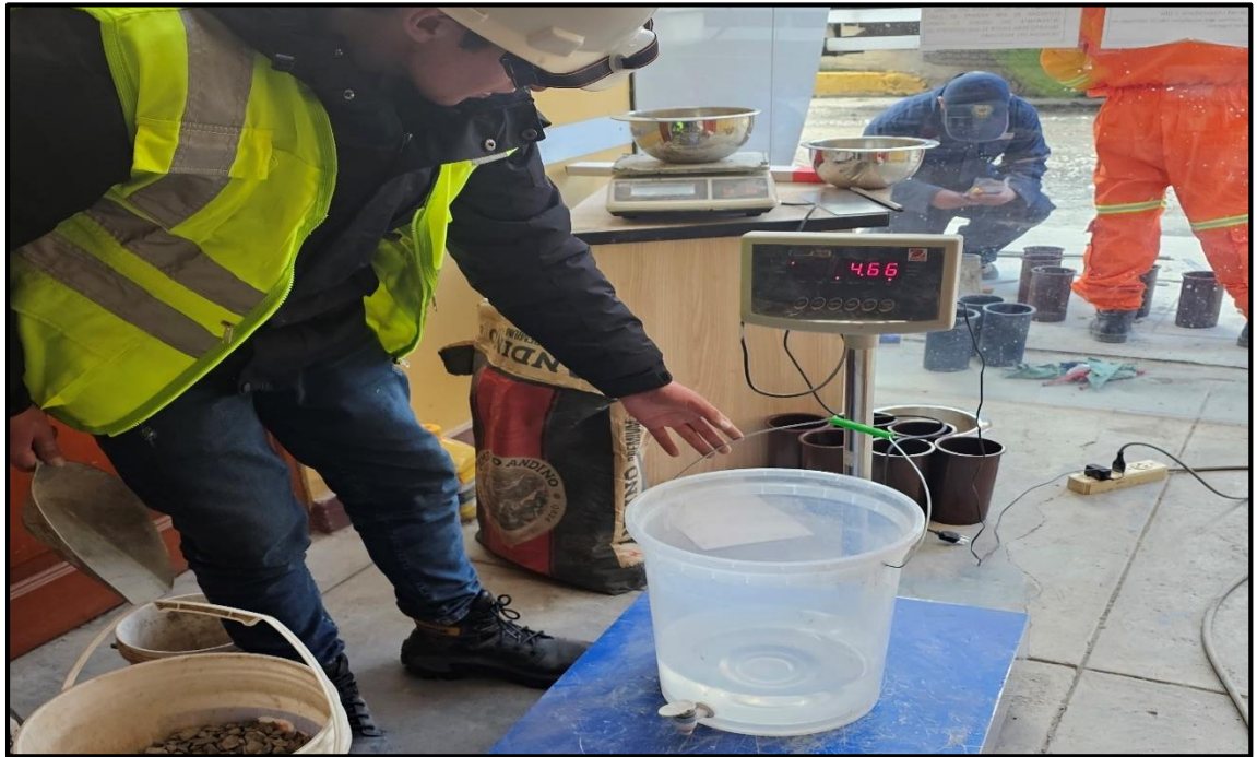
Fotografía 23.- Peso del material agua para la elaboración del concreto.
