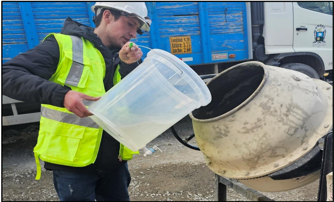
Fotografía 27.- Echado de los materiales a la mezcladora de concreto.
