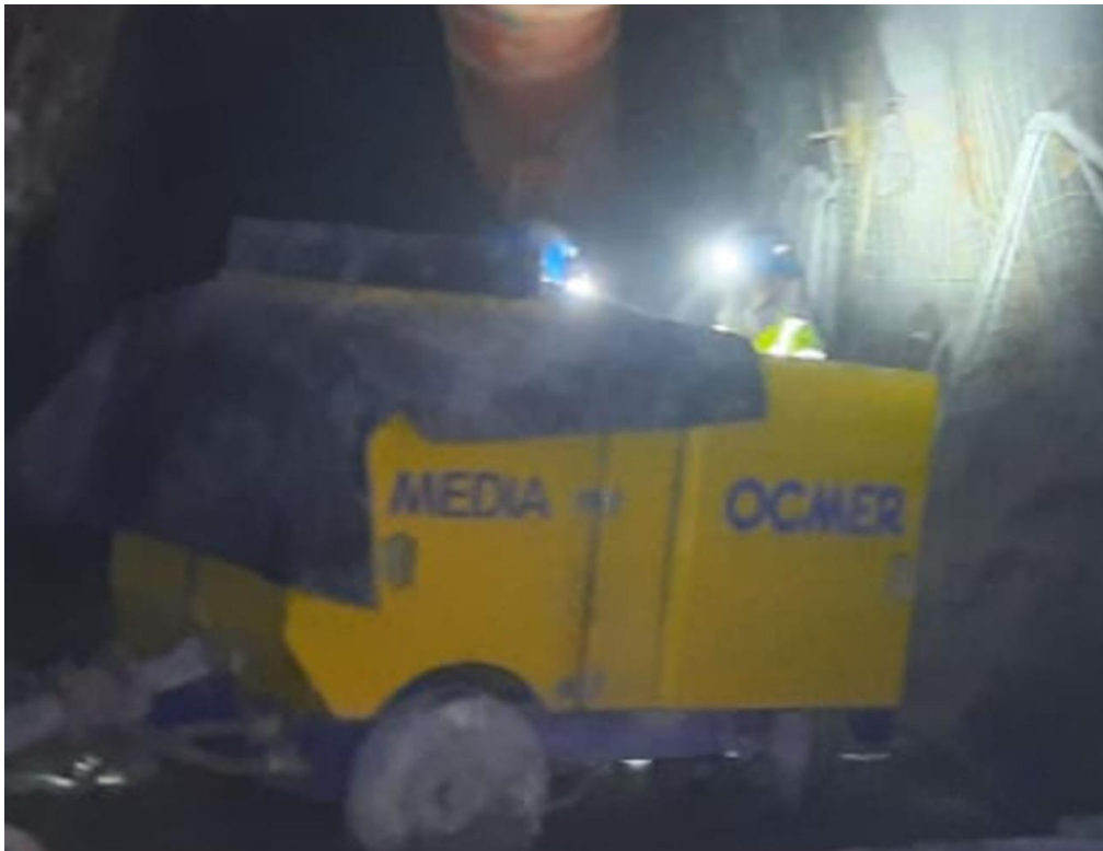
Figura 33. Trabajos de sostenimiento.
