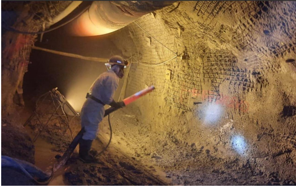
Figura 32. Sostenimiento de labores subterráneas.
