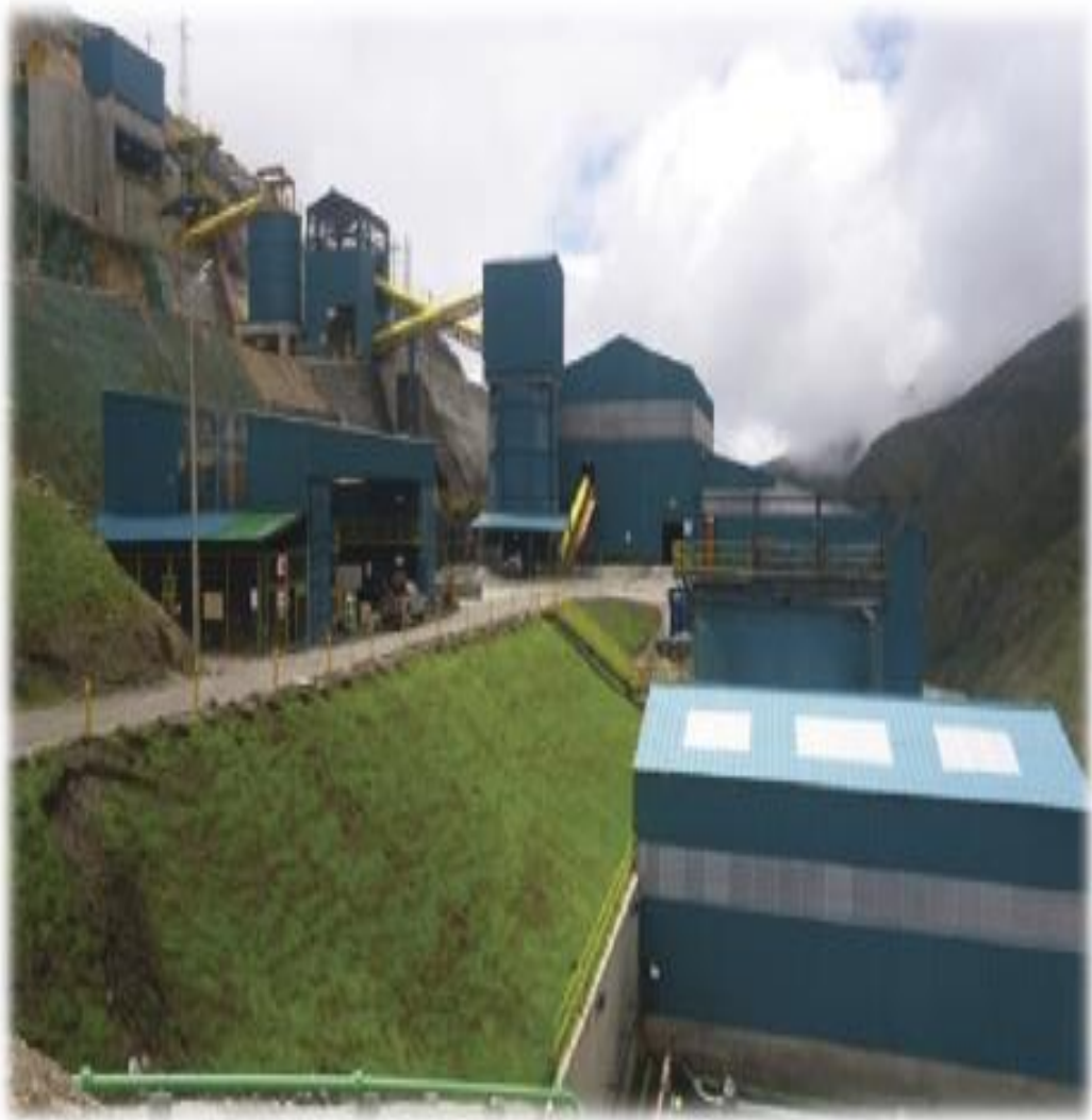
Fotografía N° 9.- Vista de la Planta Concentradora
