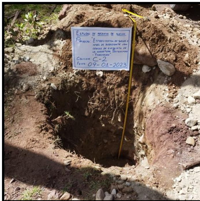
Figura 5. Zanja manual de calicata C-2.
