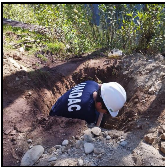
Figura 6. Excavación manual de calicata C-3.
