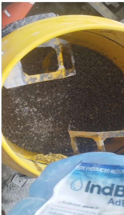
Imagen N° 35: vertimos todos los materiales y finalmente el agua para el correcto amasado de la mezcla de
