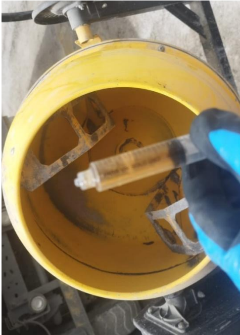
Imagen N° 33: medimos la cantidad de aditivo para realizar la tanda
