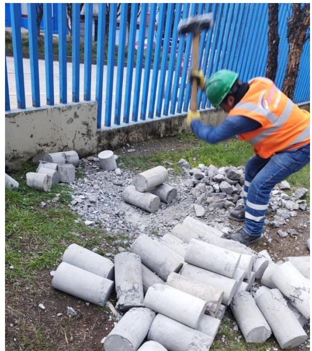
Imagen N° 4: triturando los especímenes de concreto reciclado.
