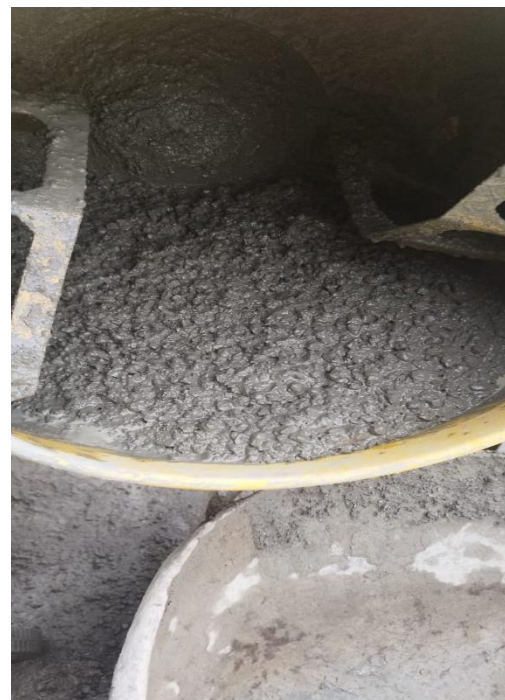
Imagen N° 36: después de todo la mezcla de concreto encontramos la mezcla con una consistencia plástica
