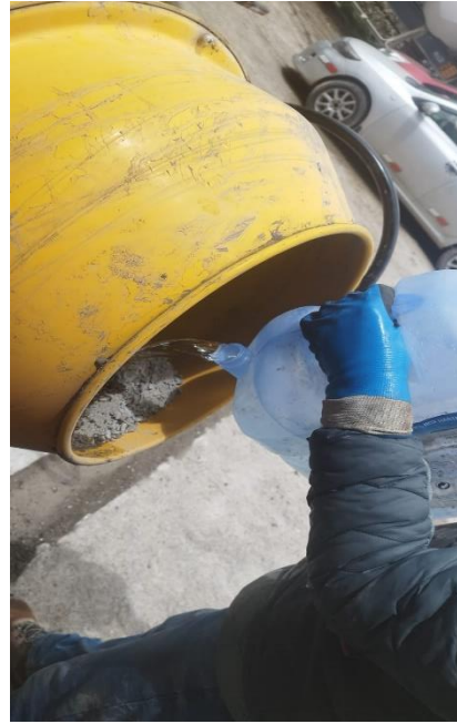
Imagen N° 34: vertimos primer el agua para realizar la tanda
