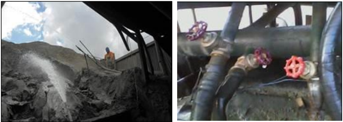
Ilustración 25. Tolva de Relave y Preparación de la Pulpa para Lanzado.
