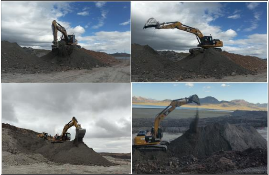
Ilustración 28: Repaleo y venteado del relave filtrado con equipo excavadora.
