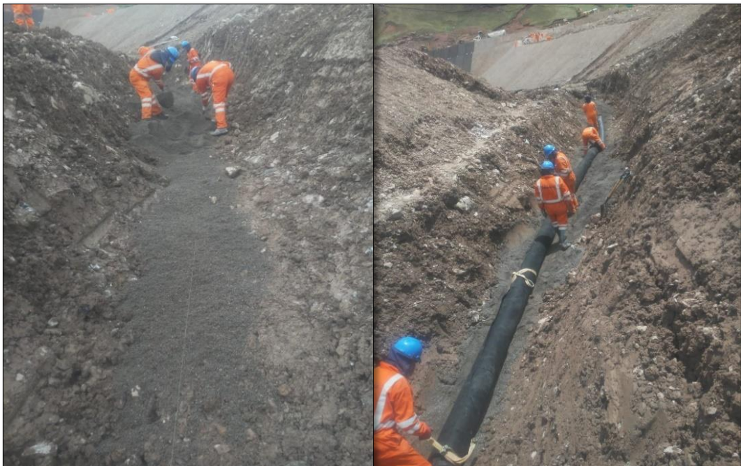
Ilustración 18: Colocación e instalación de tubería para el sistema de subdrenaje.
