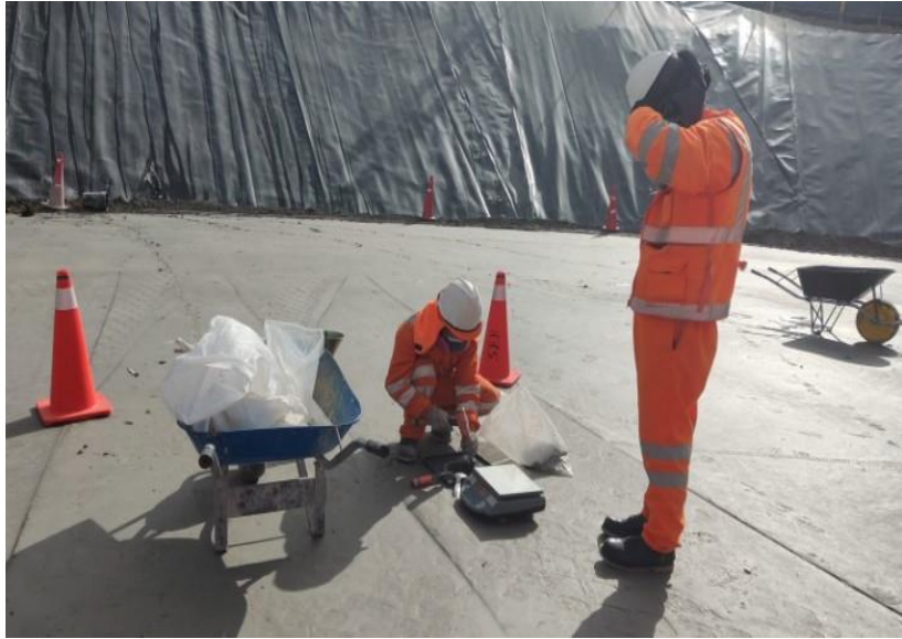
Imagen 09: Realización del ensayo de densidad en campo mediante la prueba del Cono de Arena.
