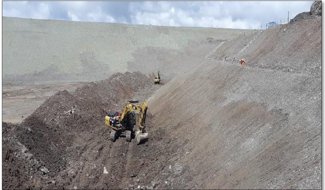
Ilustración 19: Perfilado de talud para colocación de capa drenante.
