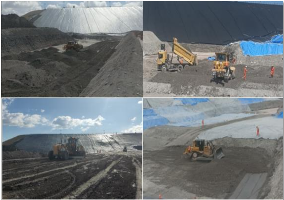
Ilustración 35: Conformación y nivelación en plataforma con equipo motoniveladora y tractor oruga.
