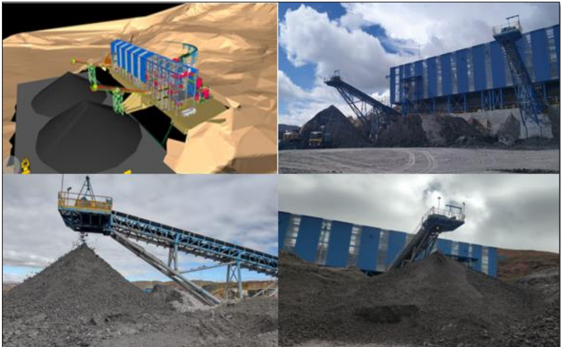
Ilustración 26: Planta de filtrado de dos fajas transportadoras.
