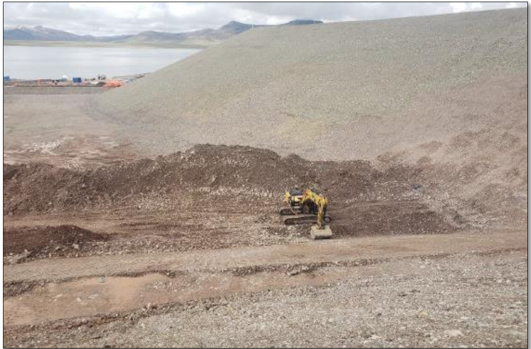
Ilustración 17: Excavación de zanja con equipo para colocación del subdrenaje.
