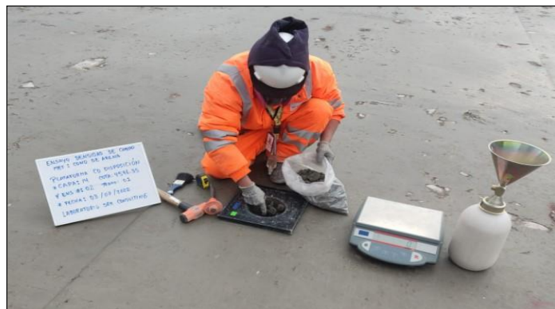
Ilustración 37: Prueba de densidad en campo - ensayo de cono de arena.
