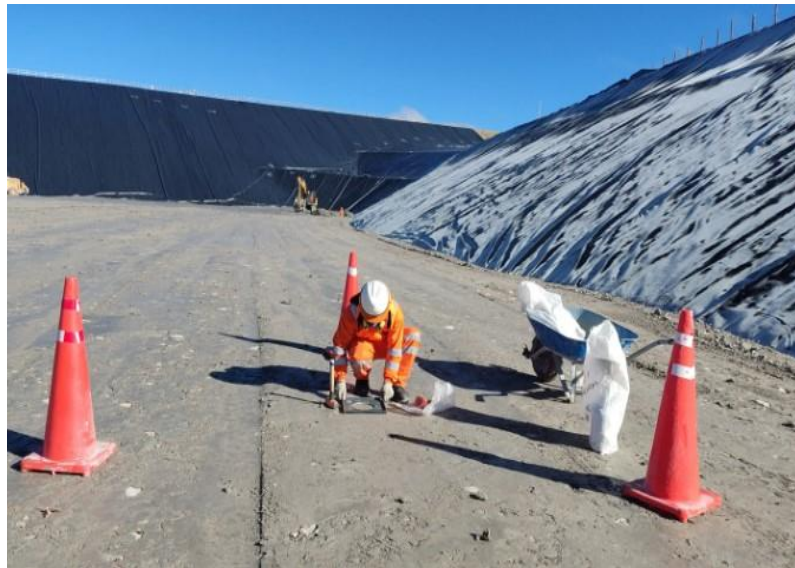
Imagen 08: Señalización y preparación del área para la ejecución del ensayo de densidad en campo – Cono de Arena.
