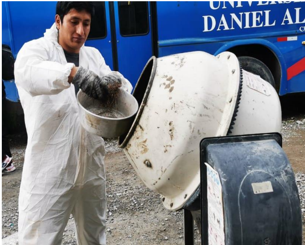
Fotografía 13. Dosificación de fibras de acero 3D para nuestro concreto.
