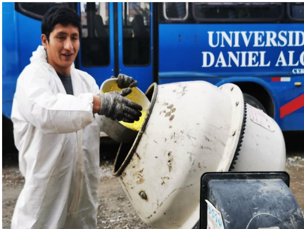
Fotografía 12. Dosificación de poliestireno expandido y fibras de acero 3D para nuestro concreto.
