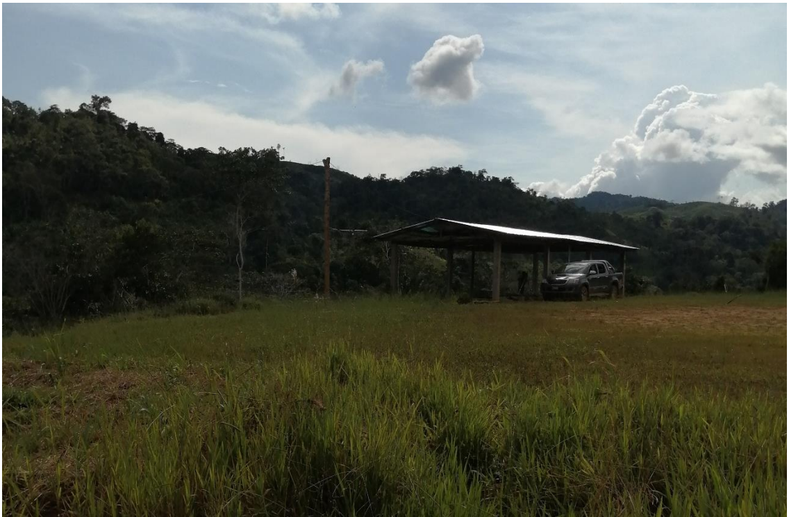
Espacio techado del lugar de la creación de los servicios deportivos con grass sintético en el centro poblado nueva Jerusalén, del distrito de Pangoa.
