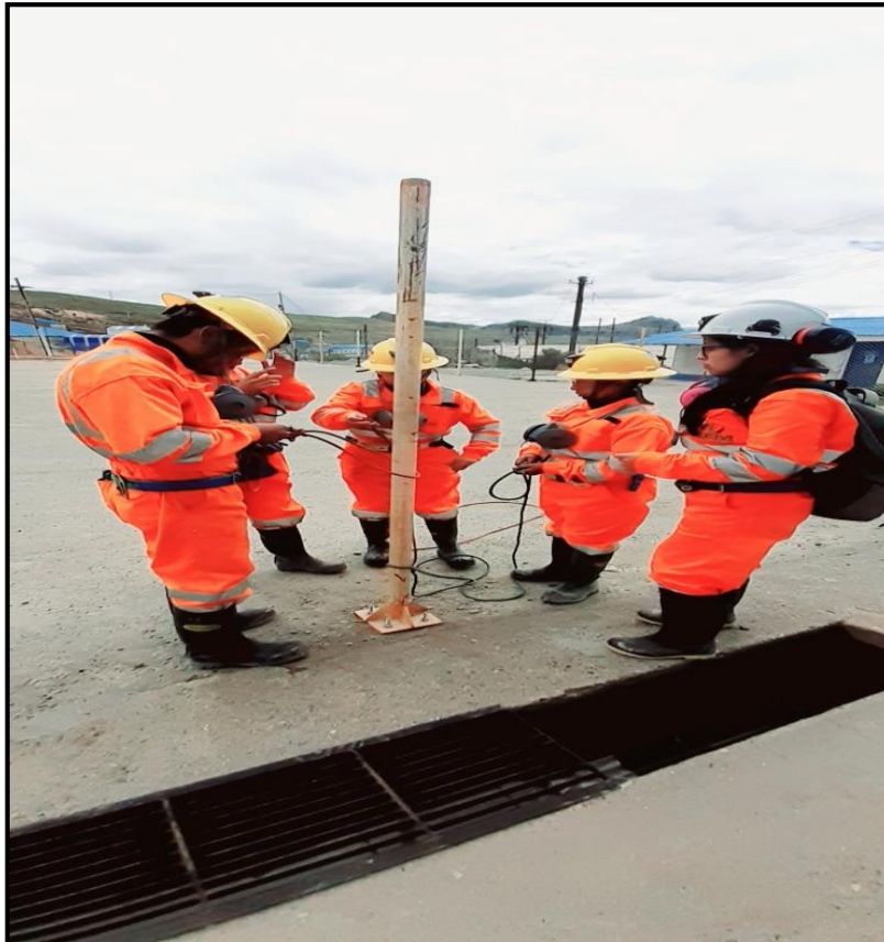
Fotografía N° 001: Vista de supervisión de actividades en la Sociedad Minera El Brocal
