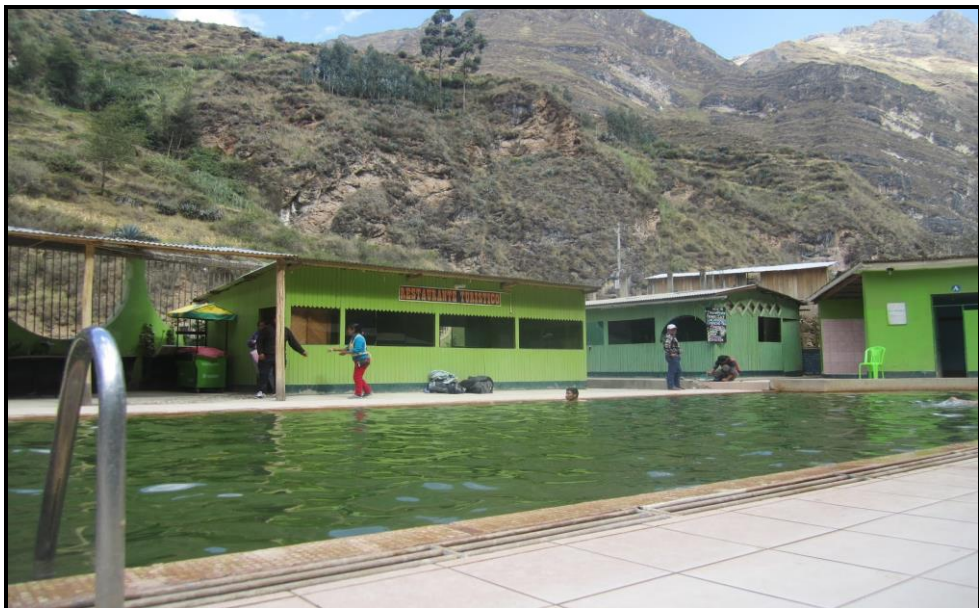
Imagen N° 4: Infraestructura de los baños termales de Tambochaca
