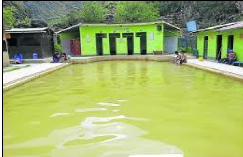
Imagen N° 3: Infraestructura de los baños termales de Tambochaca
