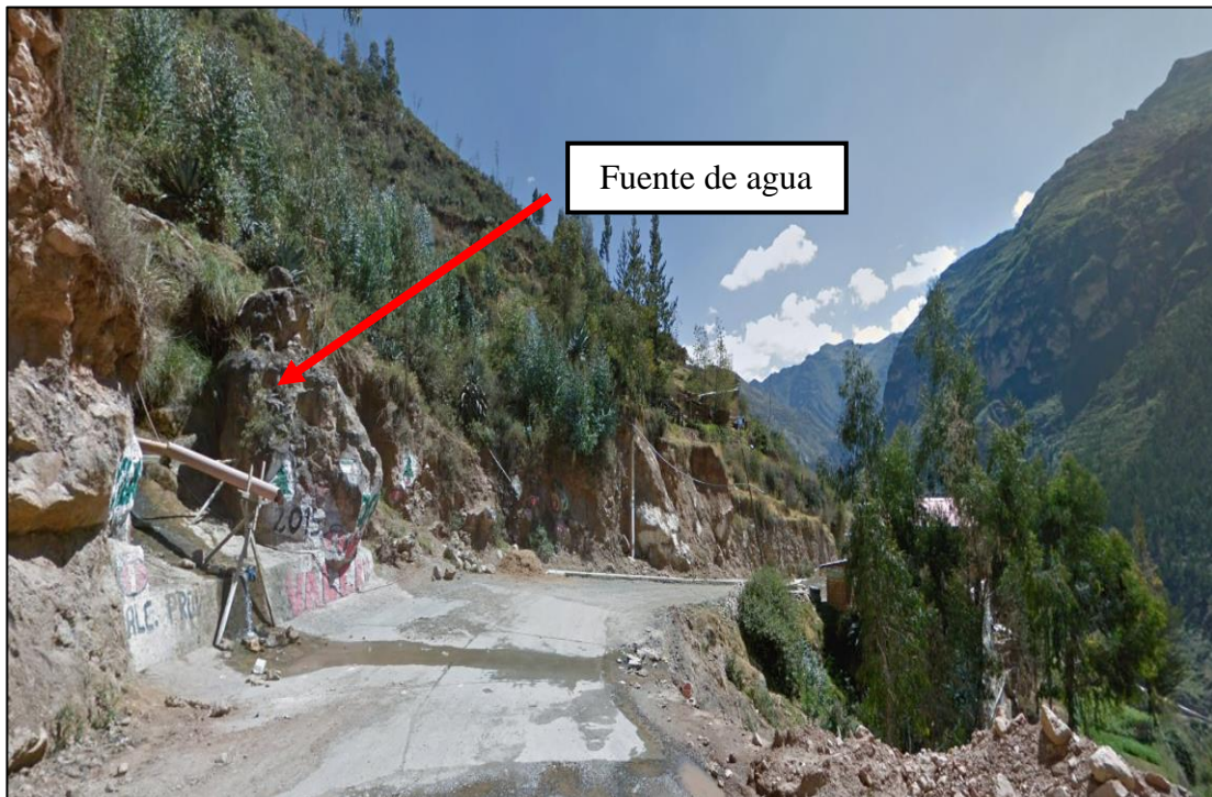
Fotografía 6. Fotografía de la fuente de agua, ubicado al SW del proyecto.
