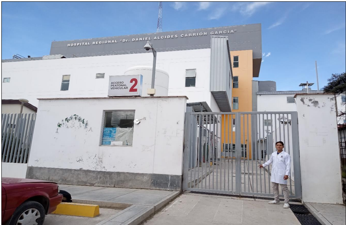
Fotografía N° 001: Vista de hospital Dr. Daniel Alcides Carrión
