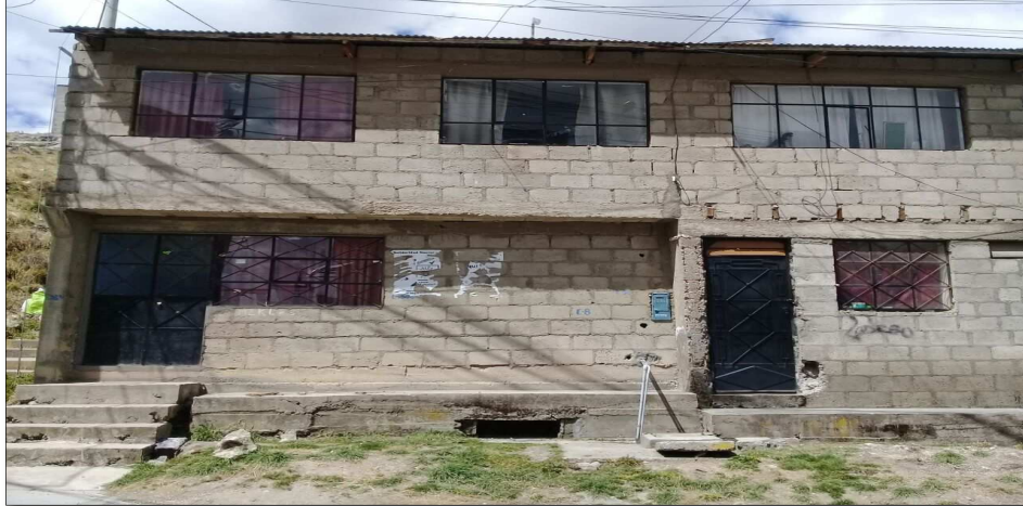
Imagen 9. Vivienda Como Muestra de Estudio 9 Fuente: Propia
