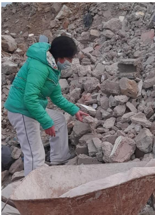
Fig. 01.- Recolección de RCD, en la zona del AA.HH. Tupac Amaru-Chaupimarca.
