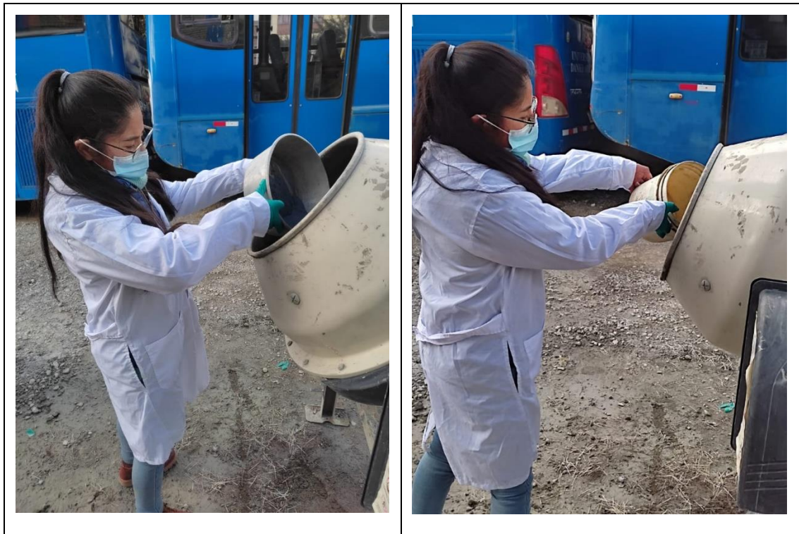
Fig. 10.- Vaciado de los materiales, para el mezclado de concreto.
