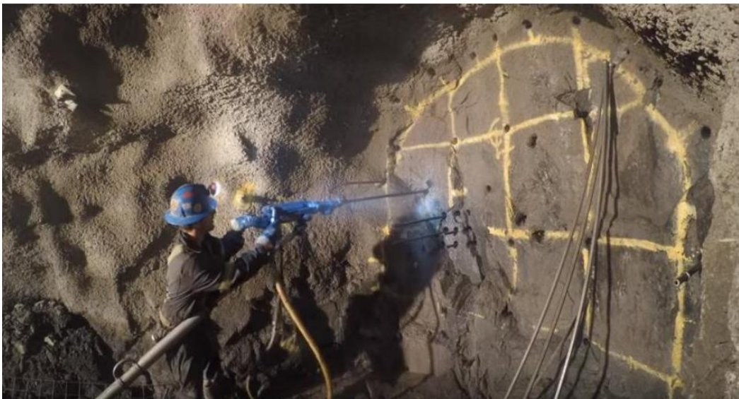
Figura 35. Malla de perforación y posicionamiento de perforadora
