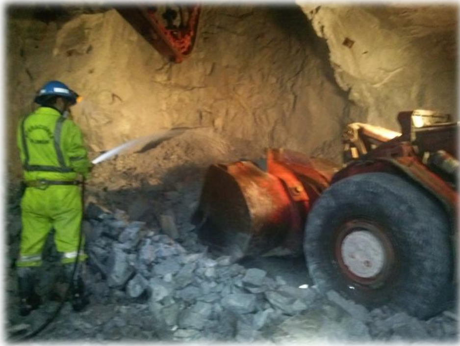
Aplicación de riego de material para mitigar la contaminación por polución
