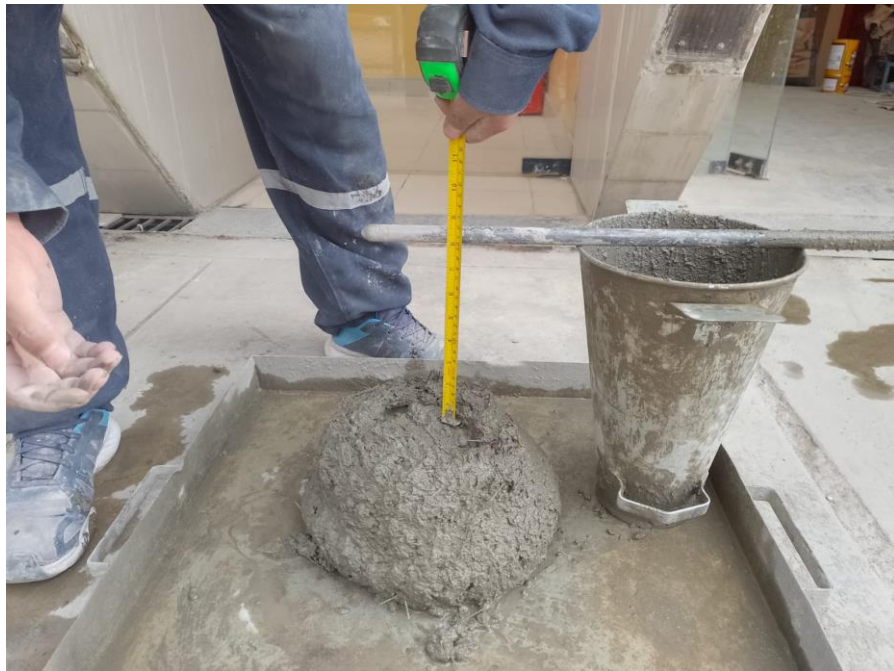
FOTOGRAFÍA N° 25: PRUEBA DE SLUMP
