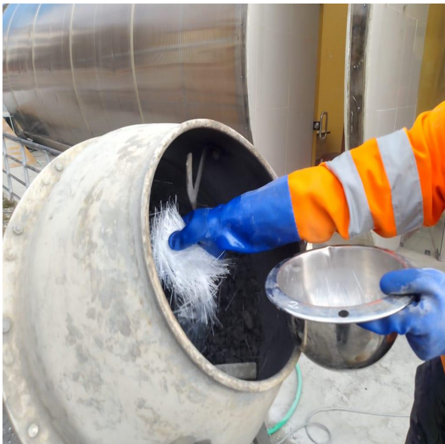
FOTOGRAFÍA N° 18: INCORPORACIÓN DE MACROFIBRA
