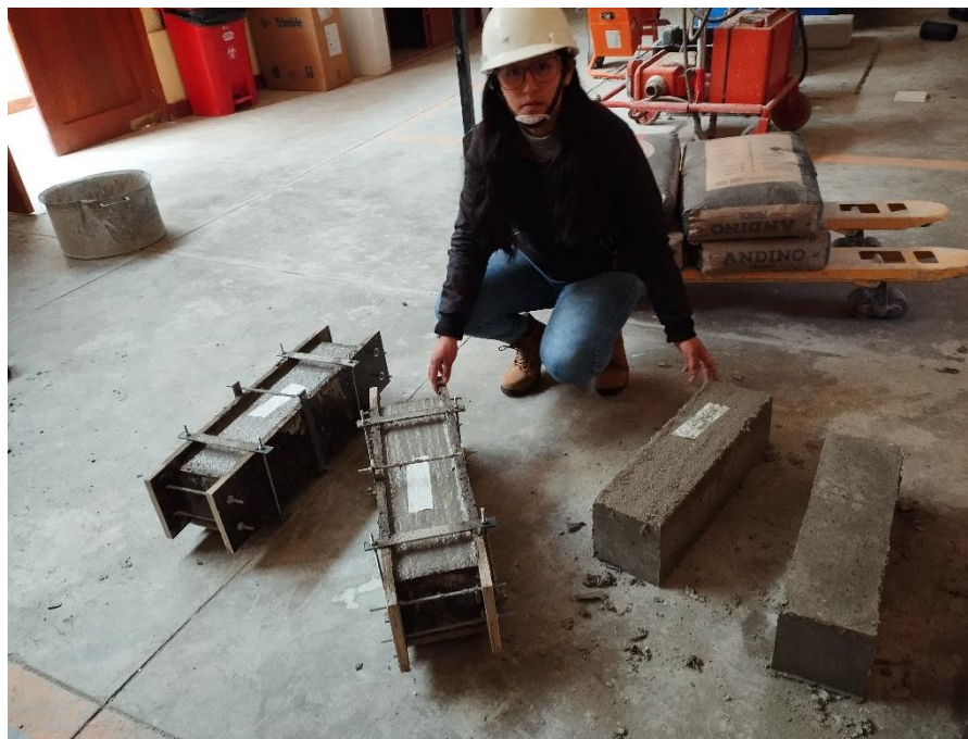
FOTOGRAFÍA N° 26: DESENCOFRADO DE VIGAS
