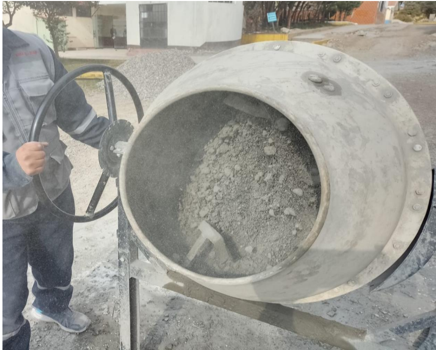
FOTOGRAFÍA N° 17: MEZCLA DE MATERIALES
