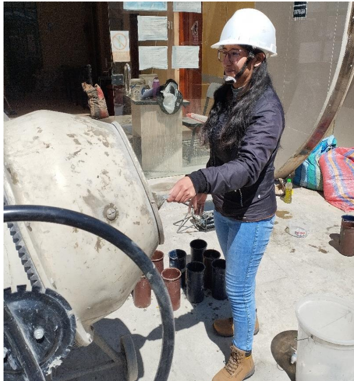
FOTOGRAFÍA N° 21: VACIADO DE MOLDES CILÍNDRICOS
