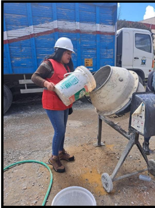
Fotografía 11.- Colocando el agregado fino en la mezcladora
