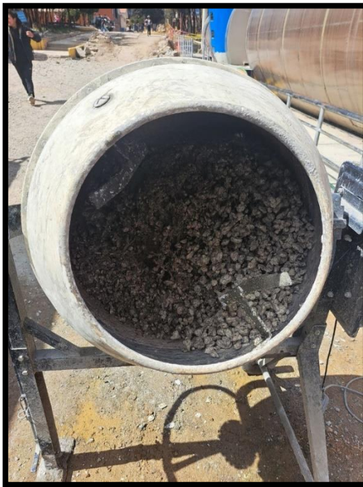
Fotografía 12.- Mezclado en máquina respetando el tiempo de mezclado normado
