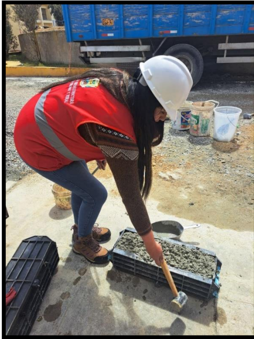
Fotografía 19.- Golpeando la superficie de la viga con mazo de goma para mejor compactación de esta
