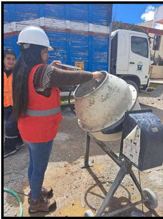
Fotografía 10.- Esparciendo las microfibras para una correcta distribución y mezclado uniforme
