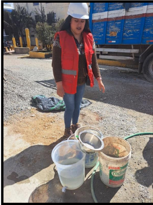
Fotografía 7.- Materiales listos para proceder con el mezclado
