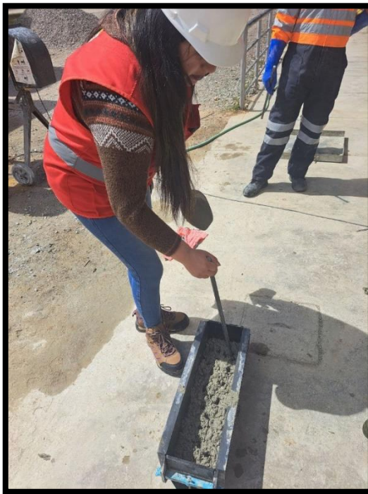
Fotografía 18.- Varillado del concreto fresco en la viga
