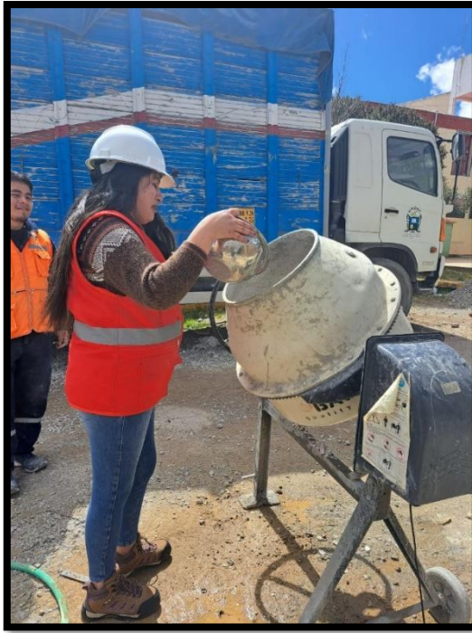
Fotografía 9.- Colocando la ceniza de calcinación en la mezcladora
