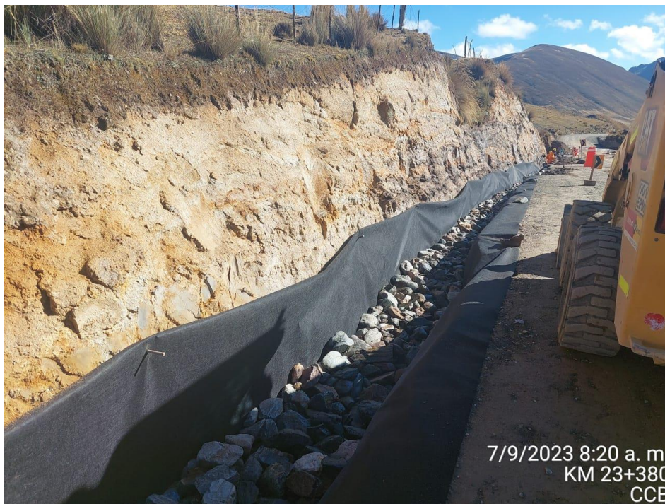
Ilustración 5: Preparación de Cama de piedras de 6 a 8" para drenaje (Fuente: Propio)
