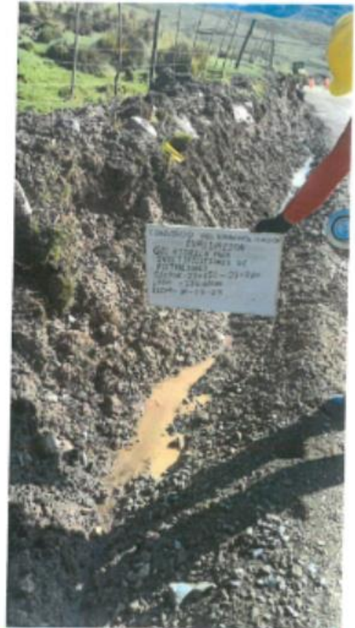
SECTOR 01 - Km. 23+150 – Km. 23+370 CALICATA N°2 PUNTO DE MUESTREO Km. 23+310 LADO IZQUIERDO
