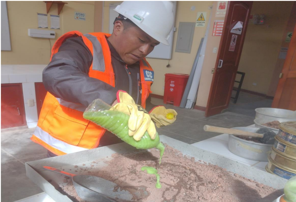
Imagen 19. Realizamos la dosificación del material + agua + la adición del mucilago de la penca de tuna en un 20% ,40% y 60 %.
