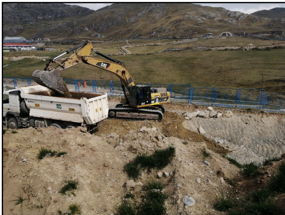
FOTOGRAFIA N°002: Excavación del terreno
