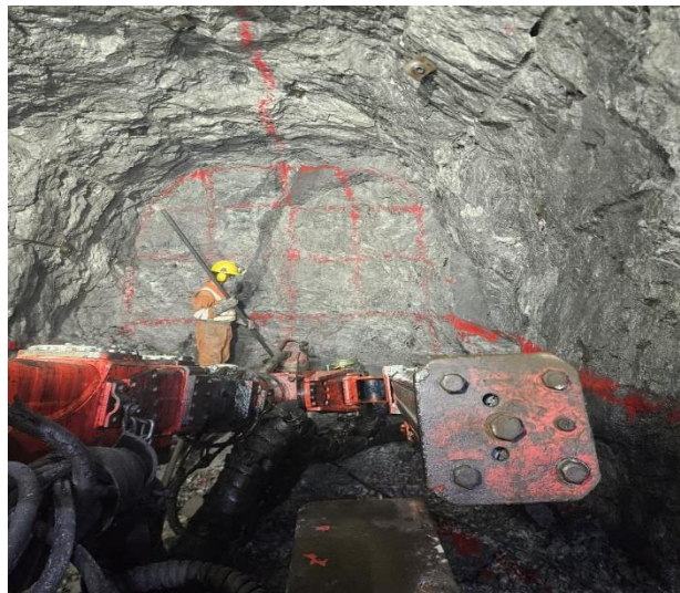
FOTO N°2: Pintado de malla de la Rampa 036.
