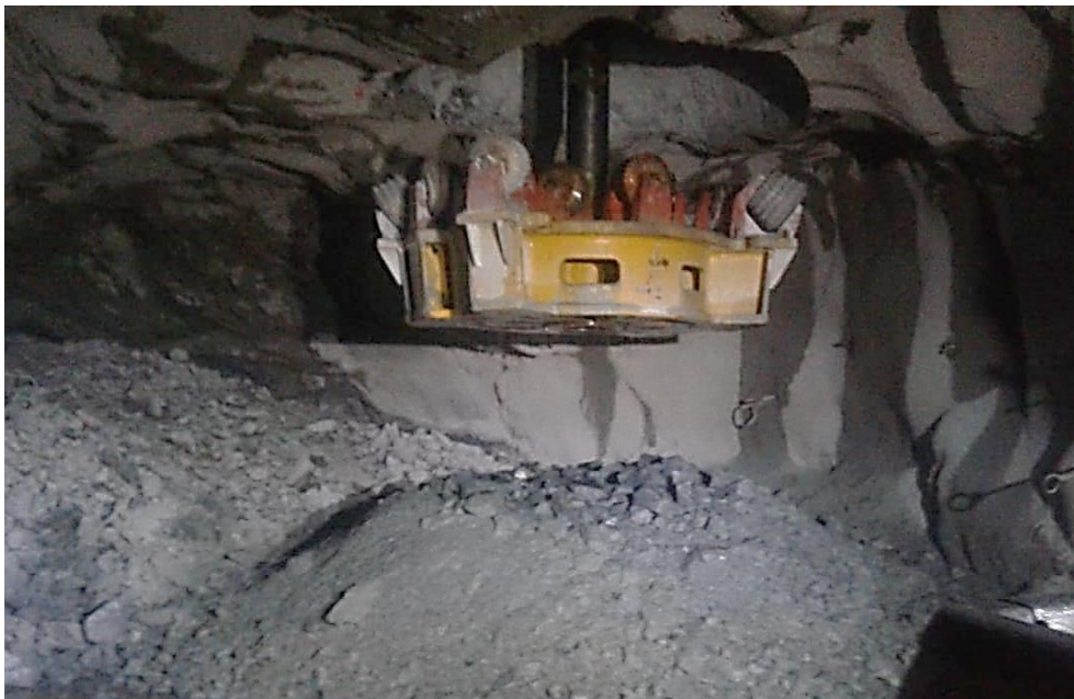
Figura 58. Rimado Controlado de la Chimenea CH2682RB – Ejecutado
