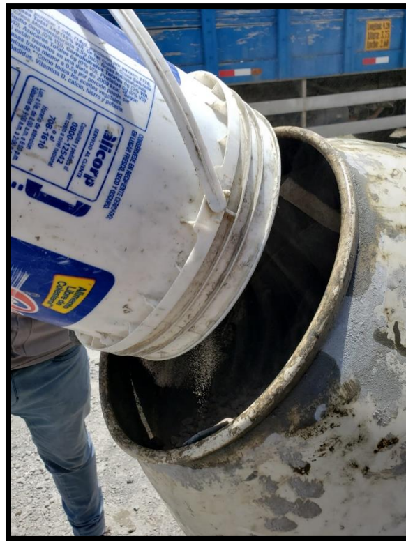
Fotografía 6.- Incorporando materiales al mezclador
