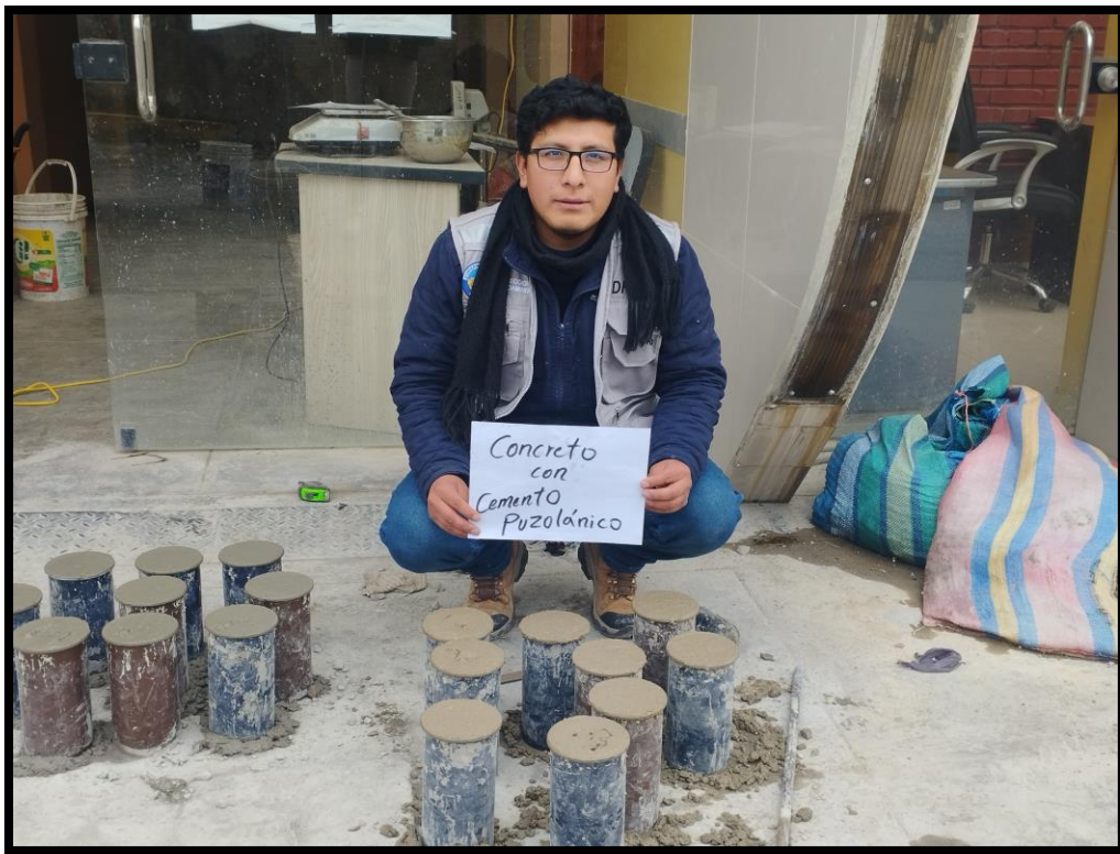
Fotografía 20.- Finalización de realización de probetas
