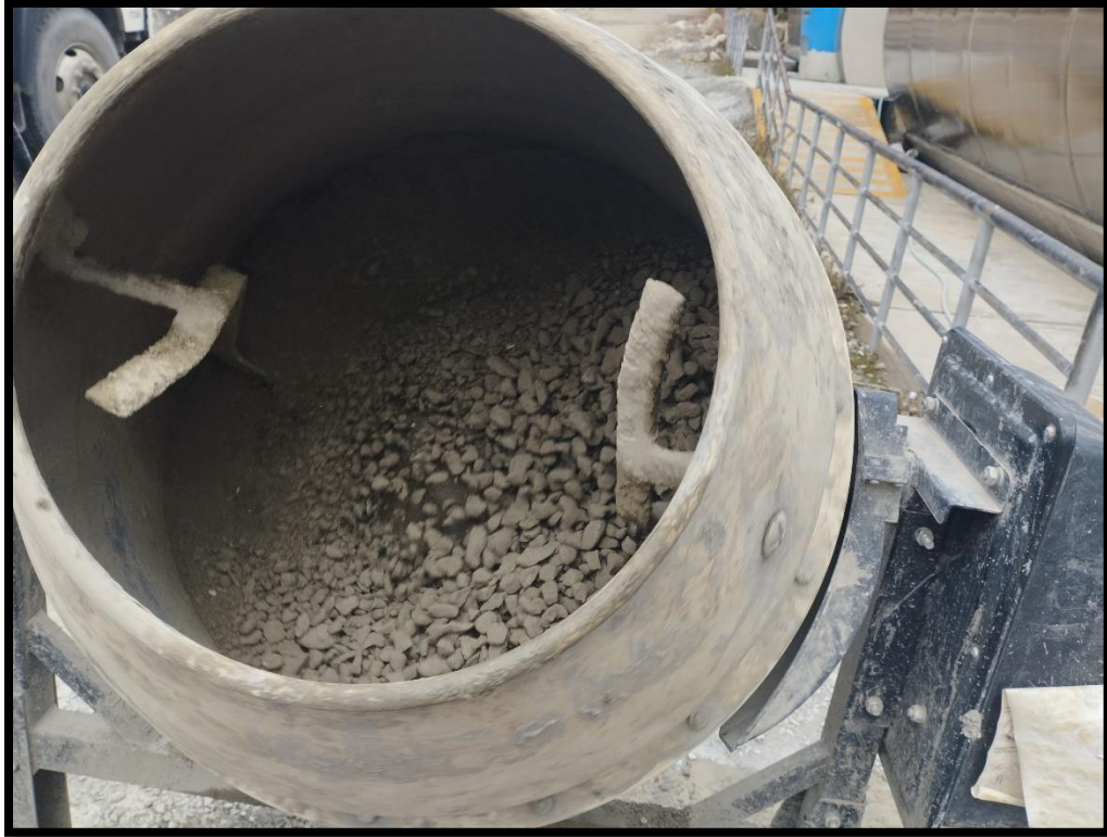
Fotografía 15.- Mezclando los materiales del concreto con cemento puzolánico
