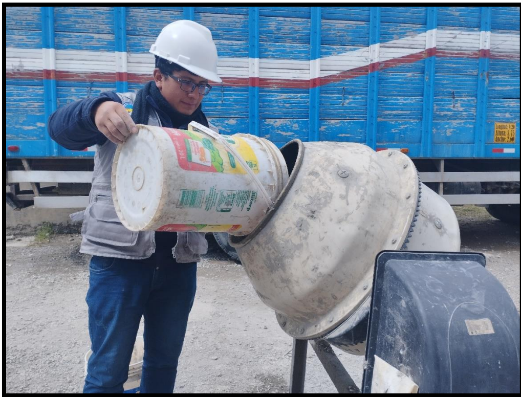
Fotografía 14.- Incorporando materiales al trompo mezclado
