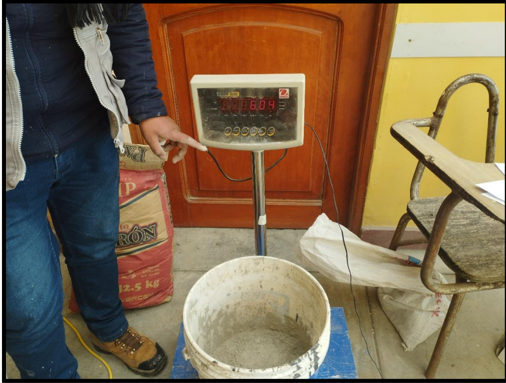
Fotografía 13.- Pesaje del cemento
