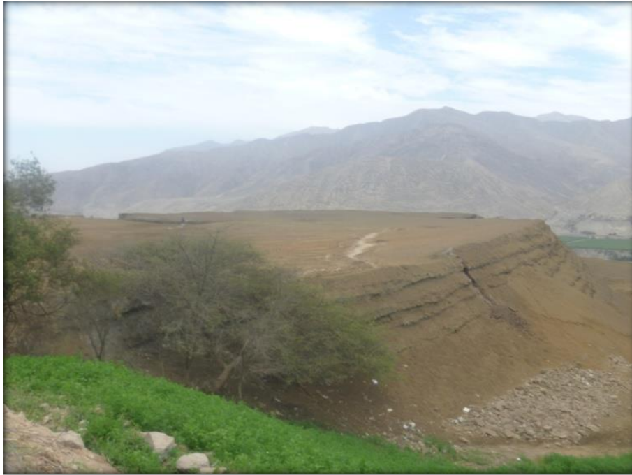
Foto 3: Vista Panorámica de la Relavera Polvareda
