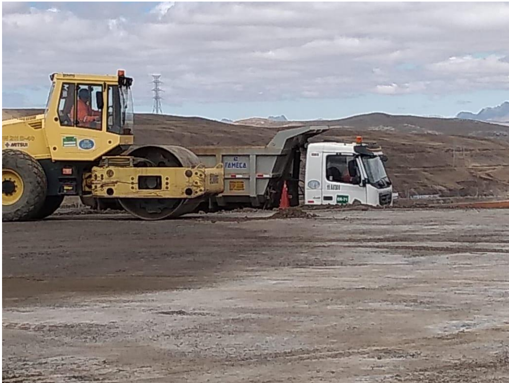
Figura 18. Compactación de plataforma 4359.09
