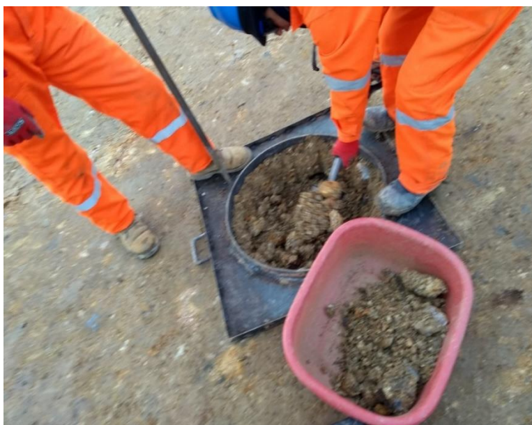
Figura 14. Excavación de agujero (0.60cm x 0,50cm)
