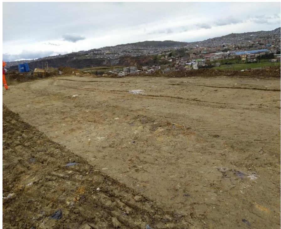
Figura 11. Preparación de terreno
