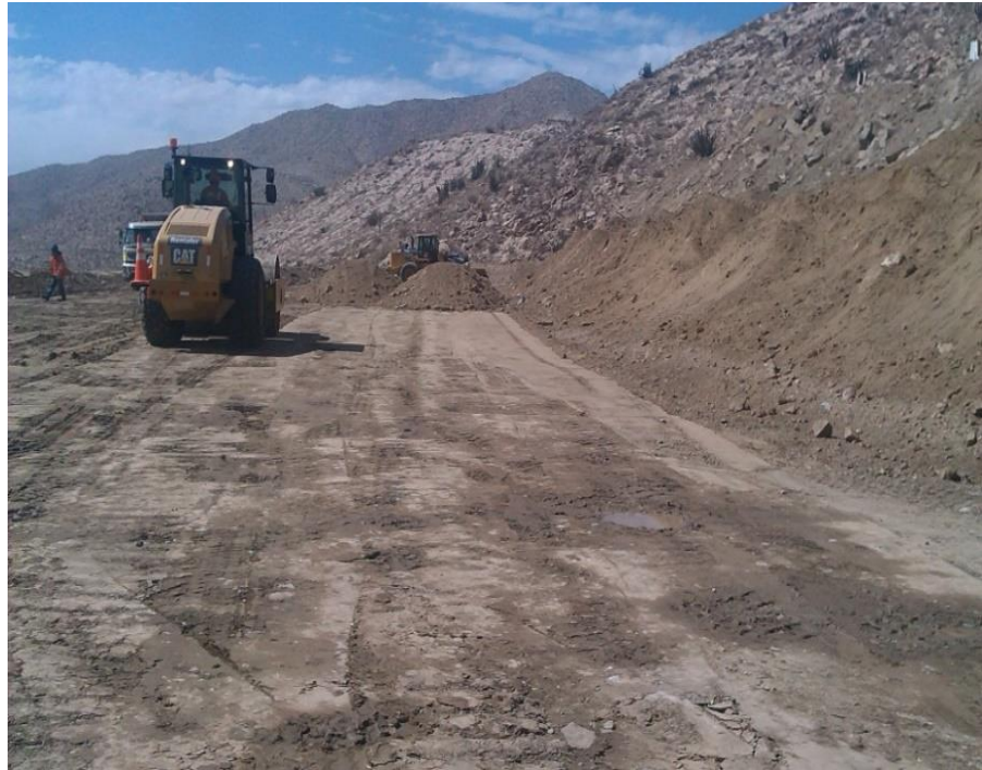
Figura 12. Compactación de suelo
