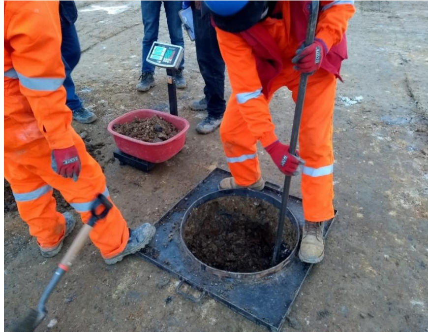
Figura 8. Excavación del hoyo para reemplazo de agua (Fuente propia)
