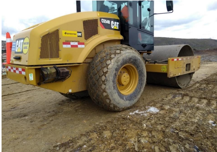
Figura 10. Compactación de área de prueba (Fuente Propia).
