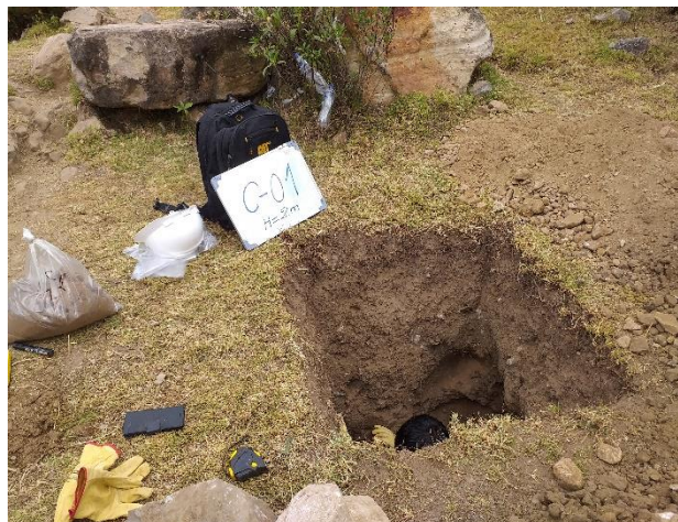
Foto 07. Estudio de suelos. Calicata N°1, ubicada en la Quebrada Chaquipa.
