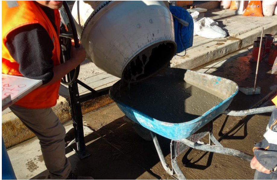
Figura 6. Vaciado de los Materiales en la mezcladora
