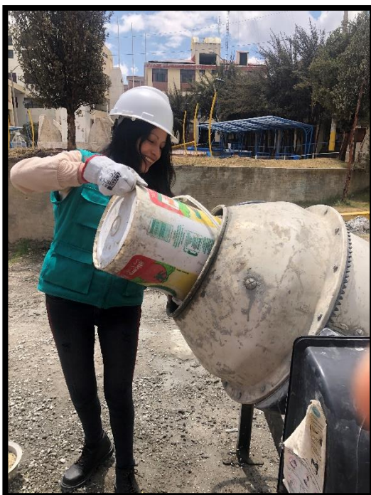
Imagen N° 10: Vaciado del agregado fino en trompo mezclador.
