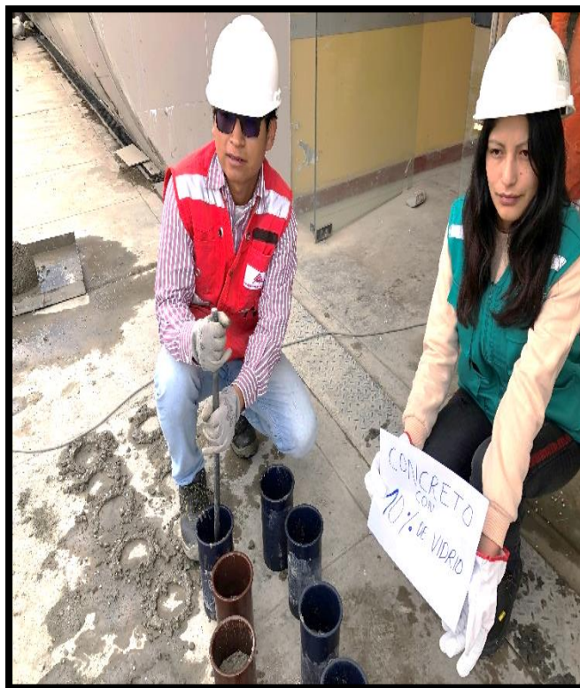
Imagen N° 18: Vaciado de concreto con 10% de vidrio molido.
