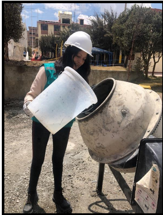
Imagen N° 12: Vaciado del agua en trompo mezclador.
