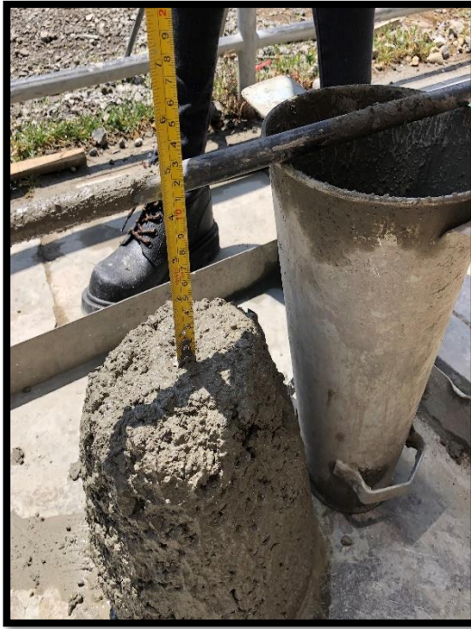
Imagen N° 25: Prueba de revenimiento para determinar el SLUMP.
