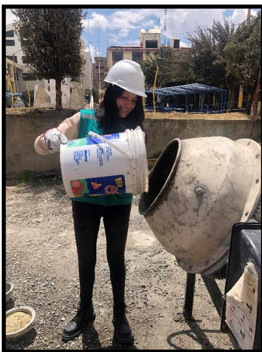
Imagen N° 09: Vaciado del agregado grueso en trompo mezclador.
