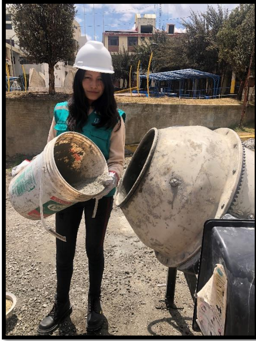
Imagen N° 11: Vaciado del cemento en trompo mezclador.
