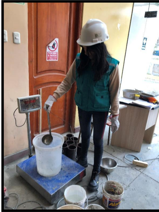
Imagen N° 05: Peso de la dosificación del agua para la mezcla de concreto.
