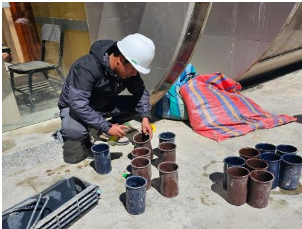
Fotografía 16. Preparación de los moldes 4" x 8" para realizar las probetas de concreto.
