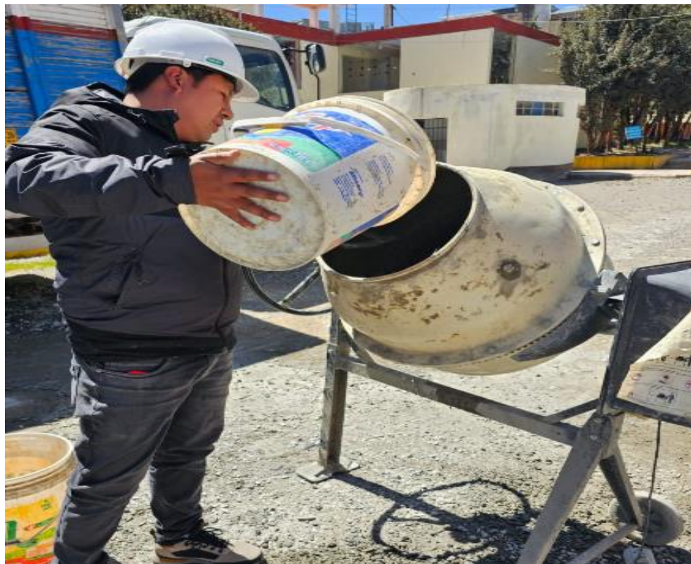
Fotografía 14. Dosificación de los materiales a utilizarse para el diseño de mezcla
