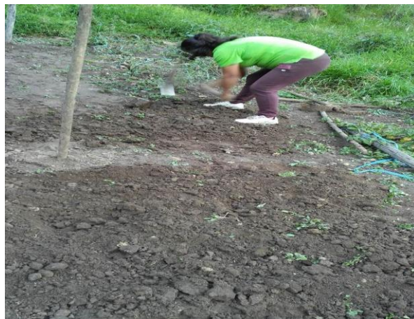
Fig. 02 Preparación del terreno
