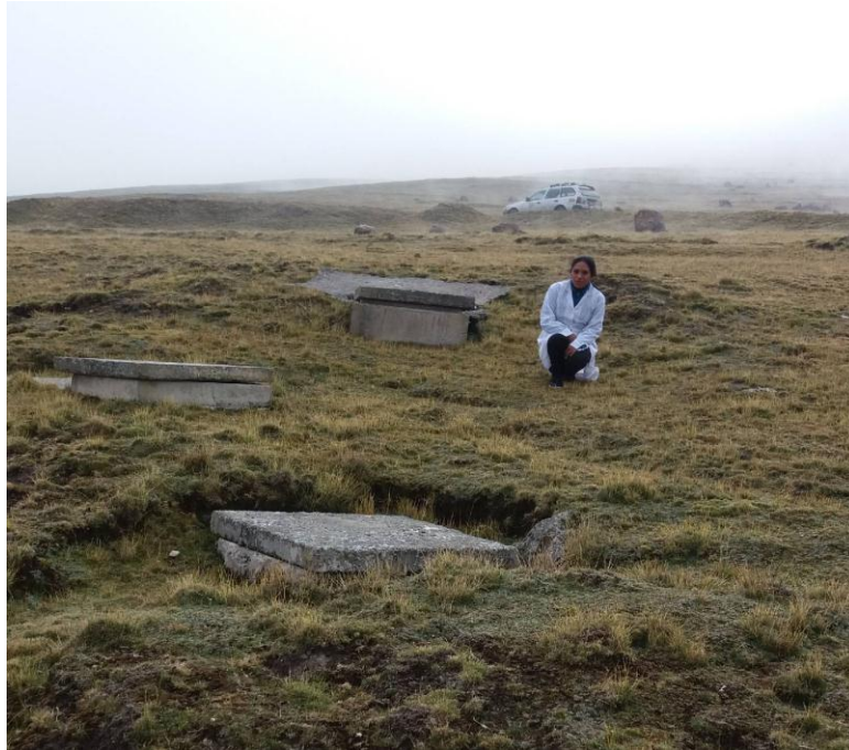
IMAGEN N° 03: Construcciones de captación de los manantiales -Cerro Condorcancha
