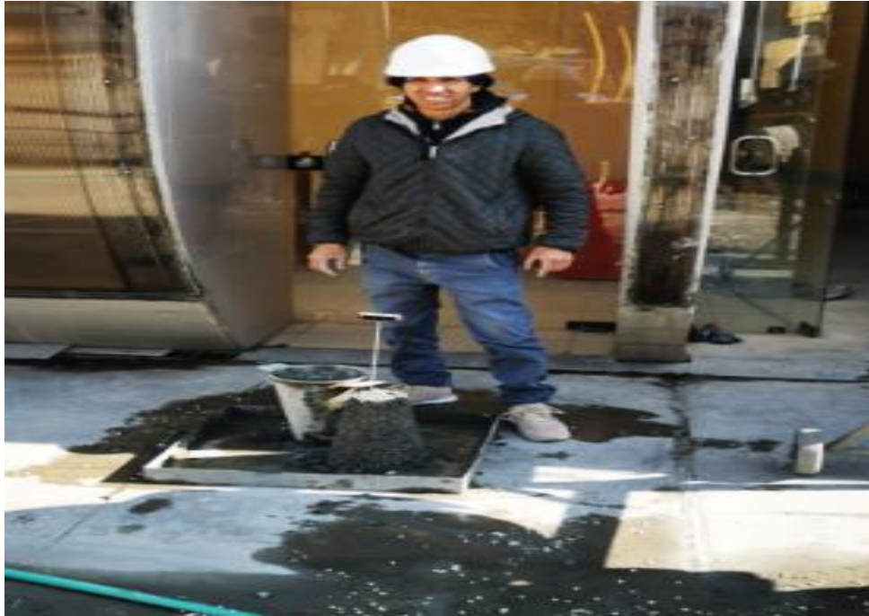
Fotografía 09. Proceso de medición del asentamiento de la mezcla de concreto
