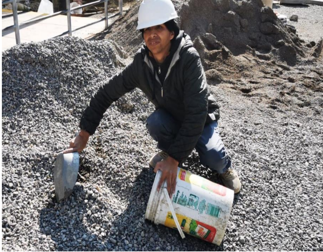
Fotografía 07. Proceso de dosificación de los agregados para el diseño de mezcla
