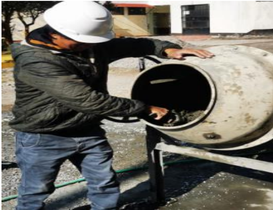
Fotografía 08. Proceso de elaboración de las probetas y vigas de concreto
