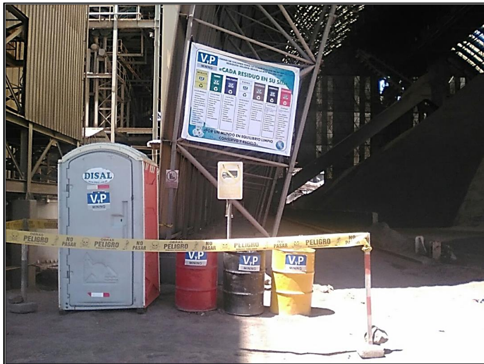
FOTO N° 2. Instalación de puntos de acopio temporales
