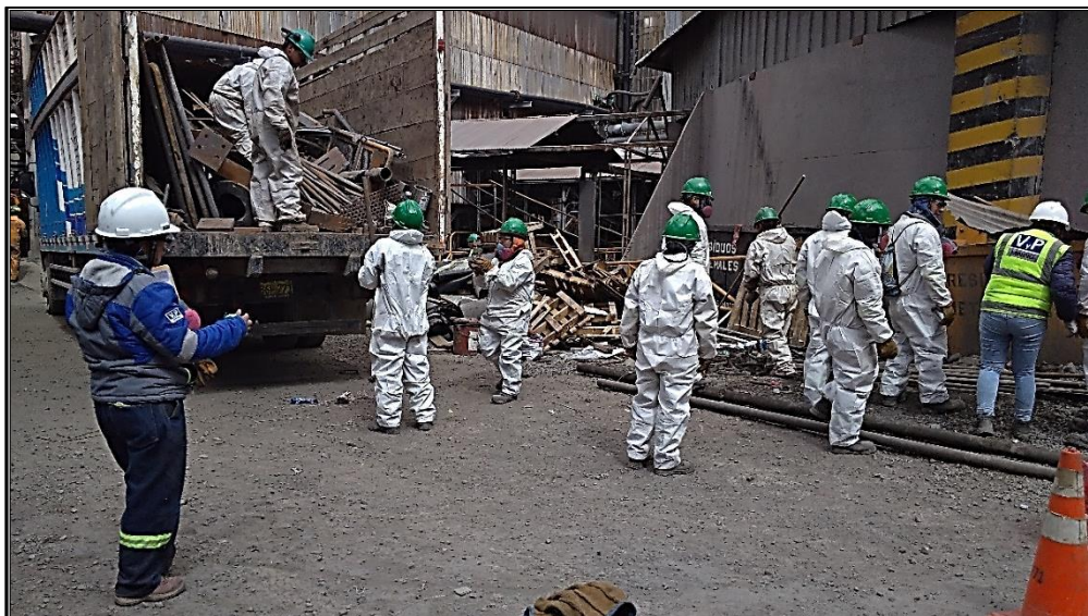
FOTO N° 5. Traslado de residuos metálicos con el apoyo de la empresa Especializada MAD SAC
