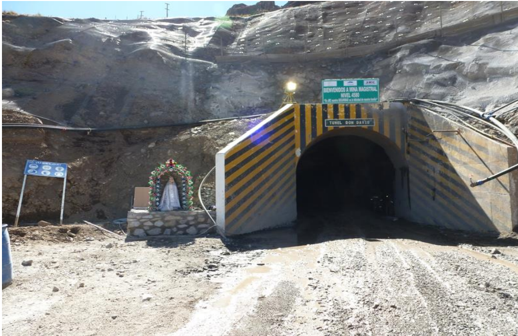
Figura 7 Ingreso Principal Operaciones subterráneas UM. Santander Túnel Don David.
