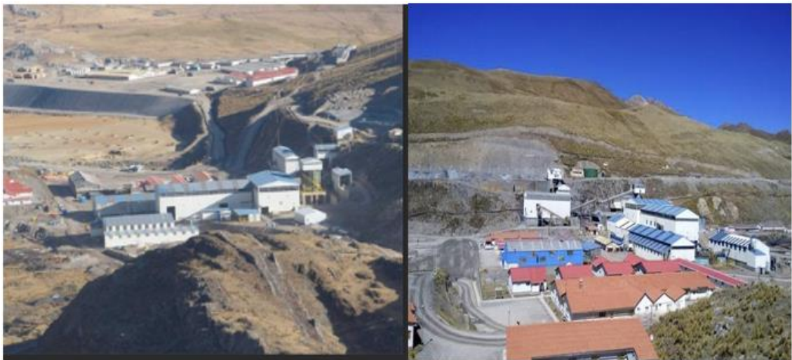
Figura 6 Instalaciones de administración de la Unidad Minera Santander
