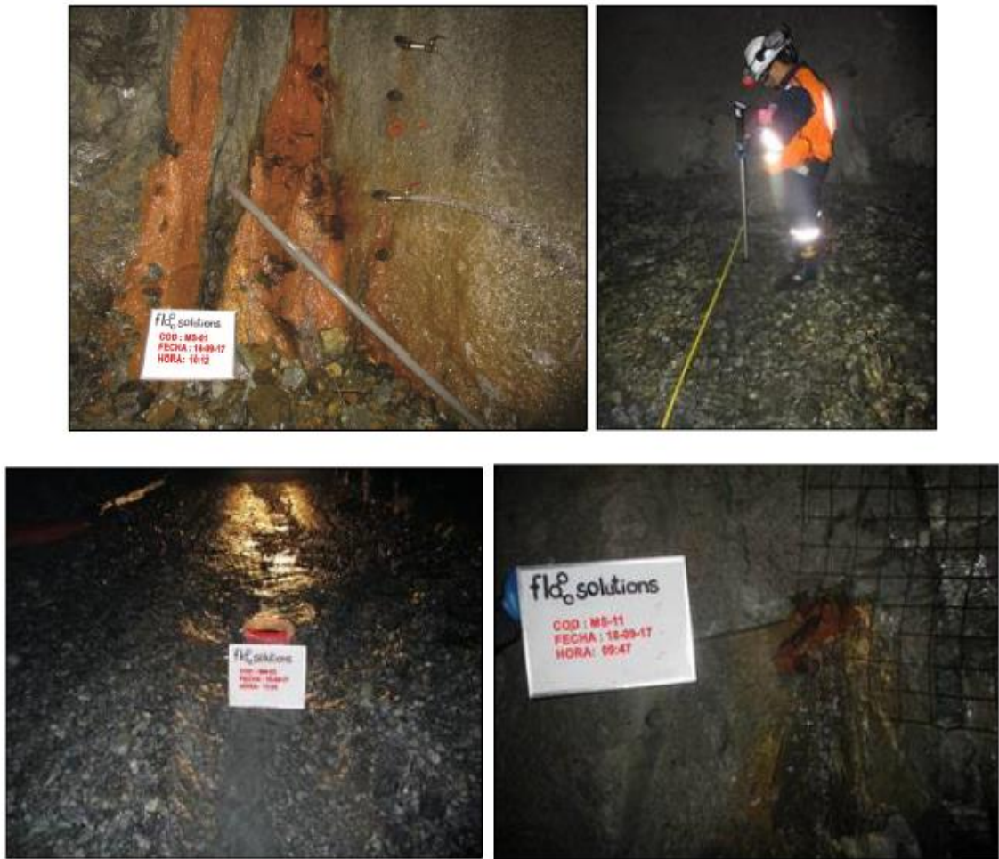
Figura 8 Filtraciones de agua desde (a) taladros (b) y (c) por el piso y (d) por fracturas
