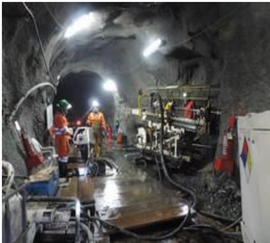
(a) Cámara de perforación con maquina diamantina
