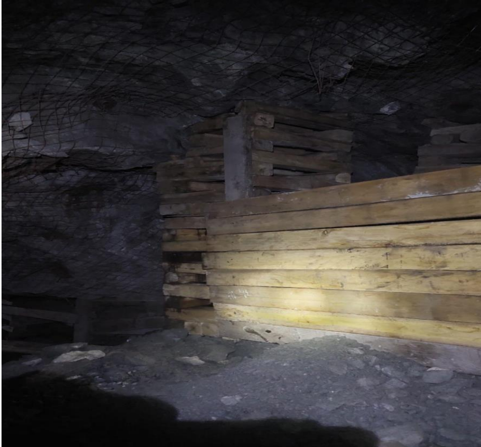
Figura 15 Sostenimiento con Wood pack
