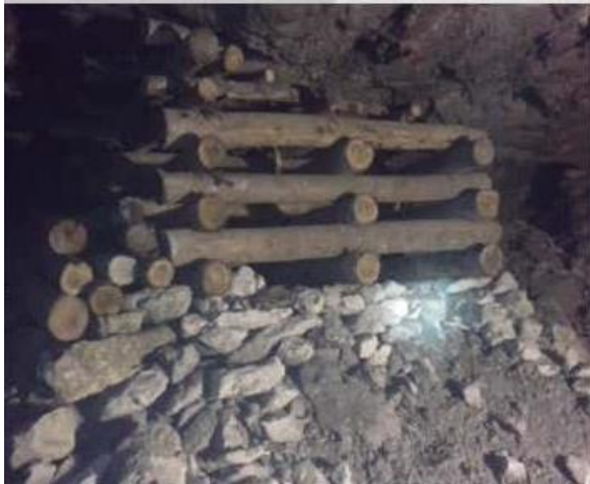
Figura 17 Sostenimiento con Wood pack
