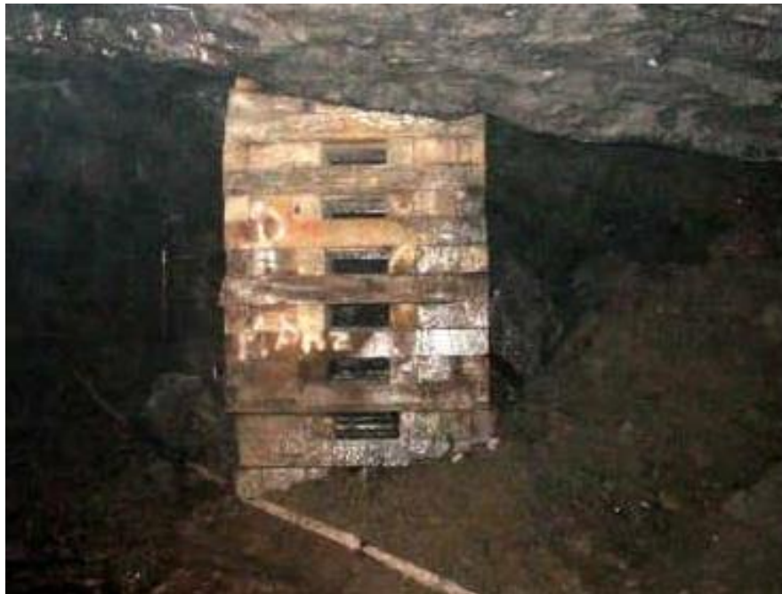
Figura 16 Sostenimiento con Wood pack
